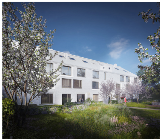
Obr.2 Pohled na fasádu ze západu
