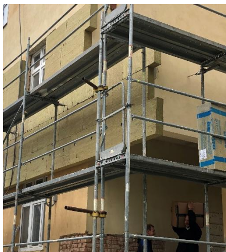
Obrázek 4- Vazba rohu lešení pomocí lešenové trubky
