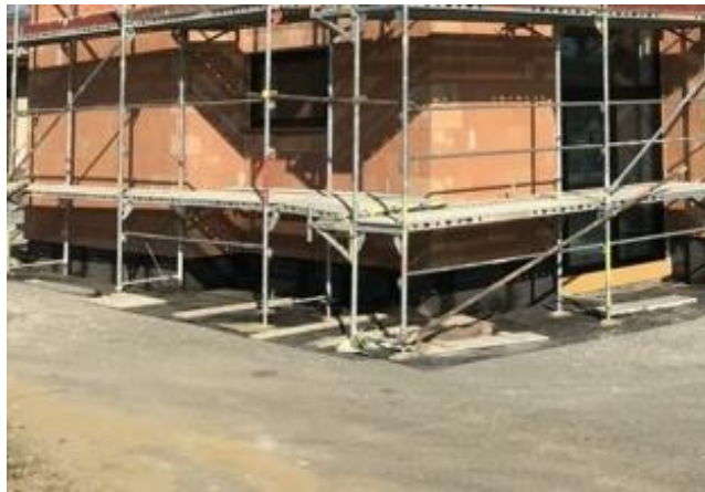
Obrázek 29- Založení lešení Layher Blitz
