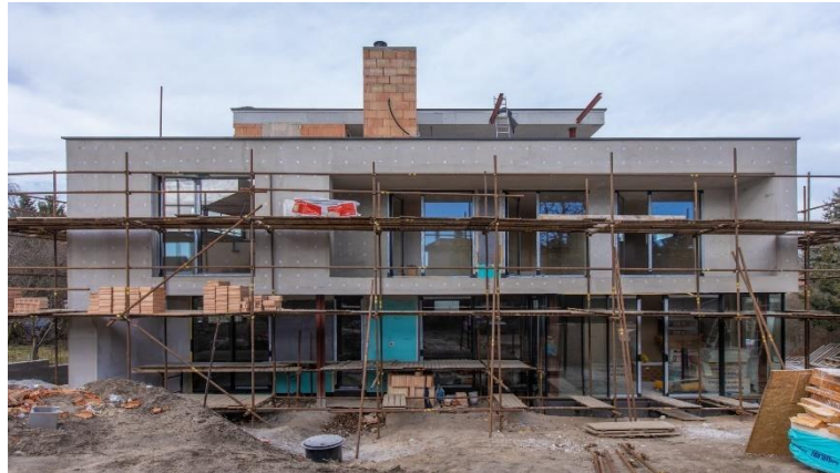
Obrázek 65- Chybějící zábradlí
