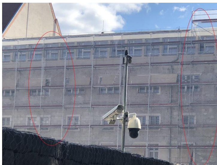
Obrázek 61- Nedostatečné zavětrování lešení
