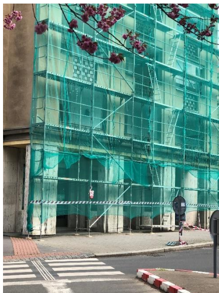
Obrázek 60- Chybějící podélník
