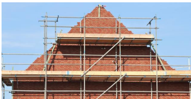
Obrázek 56- Špatné osazení diagonál
