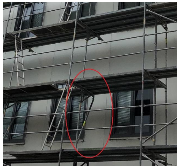
Obrázek 23- Podpora diagonály
