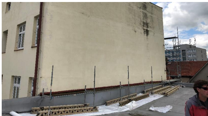
Obrázek 16- Založení pomocí příhradových vazníků
