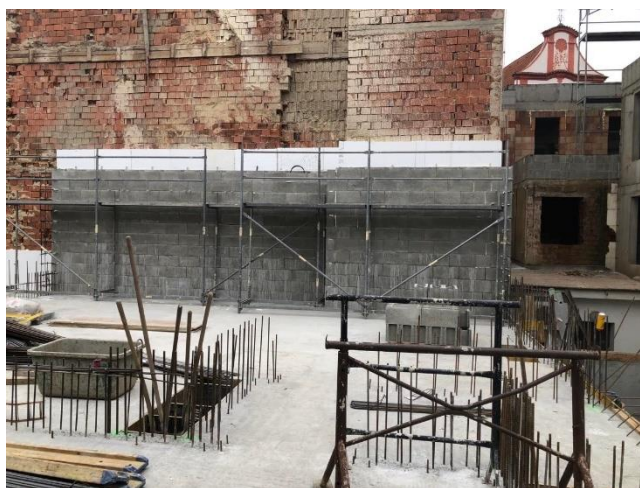
Obrázek 59- Chybějící nánožky
