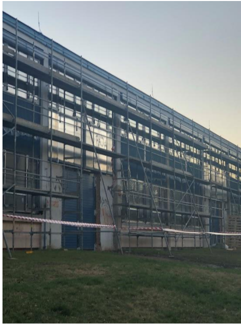
Obrázek 21- Zapření lešení bez pomoci kotev
