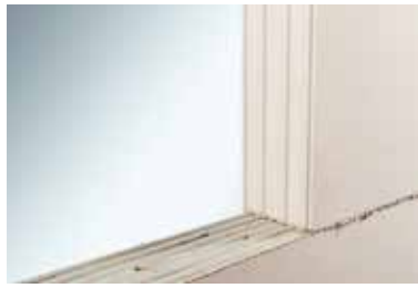
Uložení bloku do maltového lože
