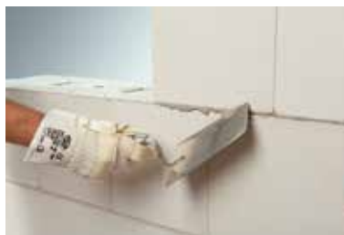
Odstranění přebytků malty hranou lžice po jejím zavadnutí
