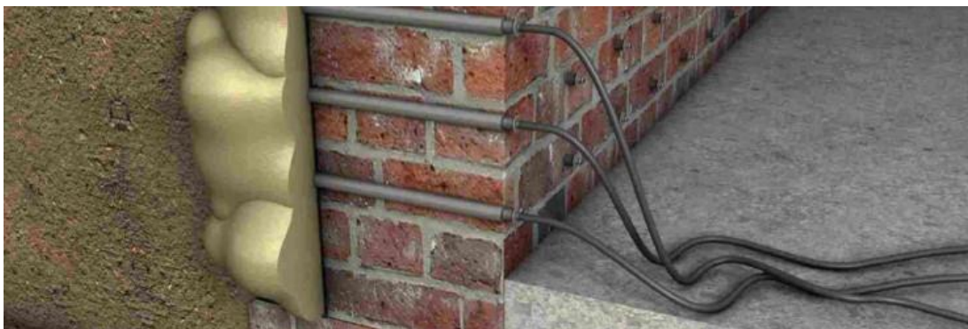
Obr. č. 10 - Rubová injektáž zdiva (zdroj [20])
