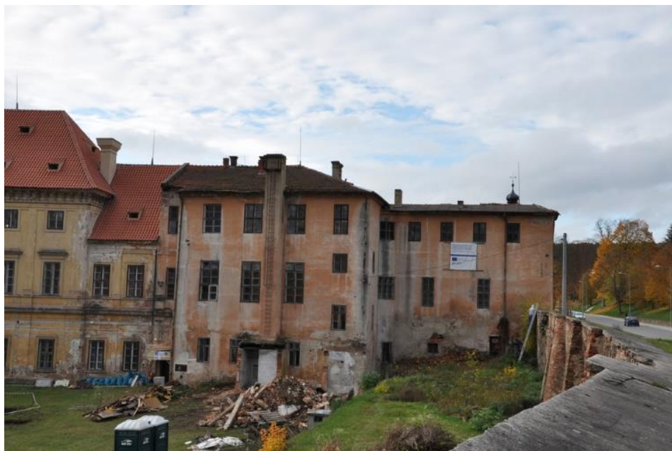
Obr. č. 26 - Budova Starého opatství před zahájením rehabilitace (zdroj [32])
