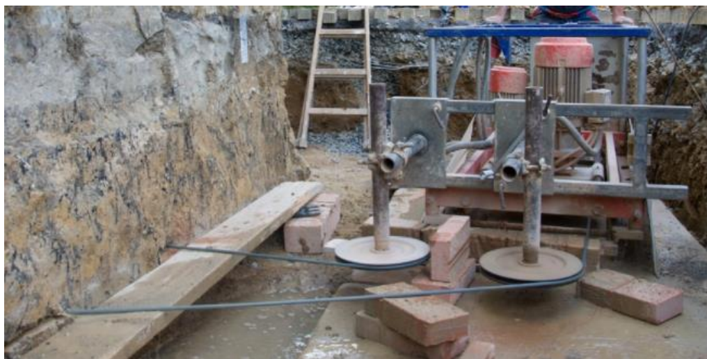
Obr. č. 7 - Podřezávání zdiva lanovou pilou (zdroj [ESTAV.cz])
