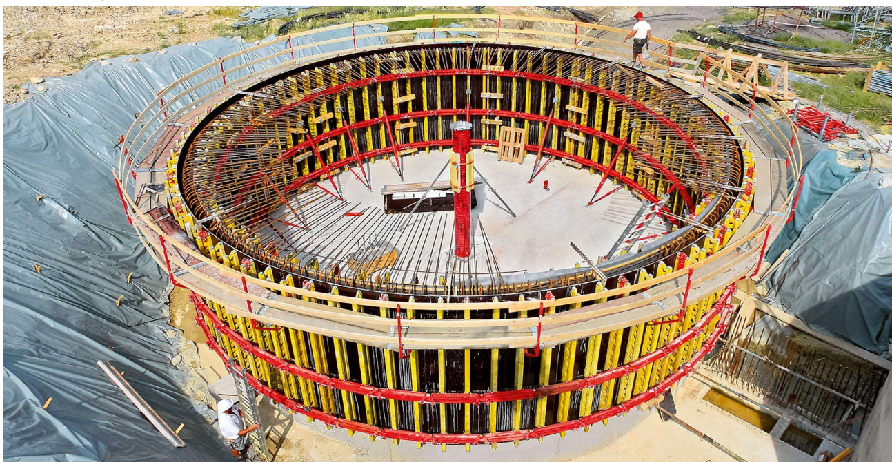
[Obr. 11 Atypické bednění od výrobce PERI]
