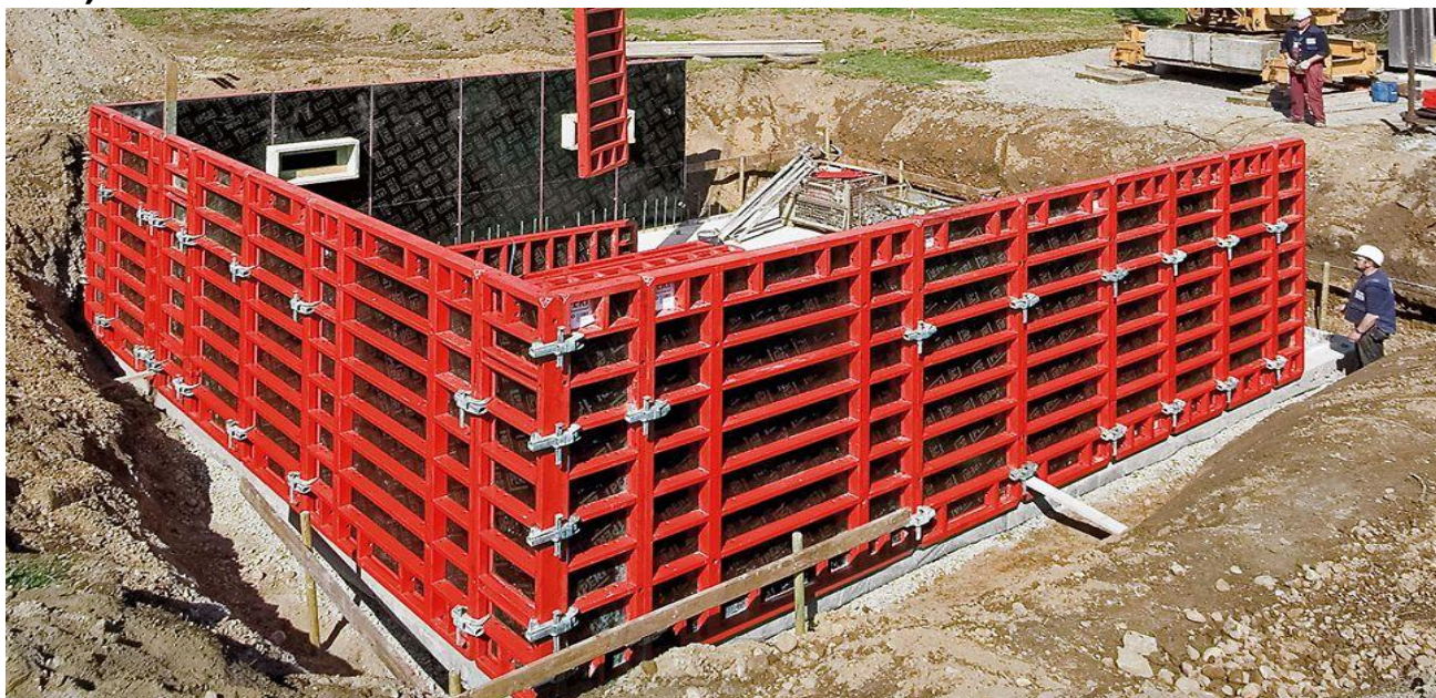
[Obr. 9 Rámové bednění od výrobce PERI]
