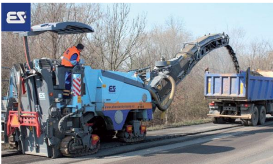
Obrázek 1 - Frézování vozovky za studena [10]
