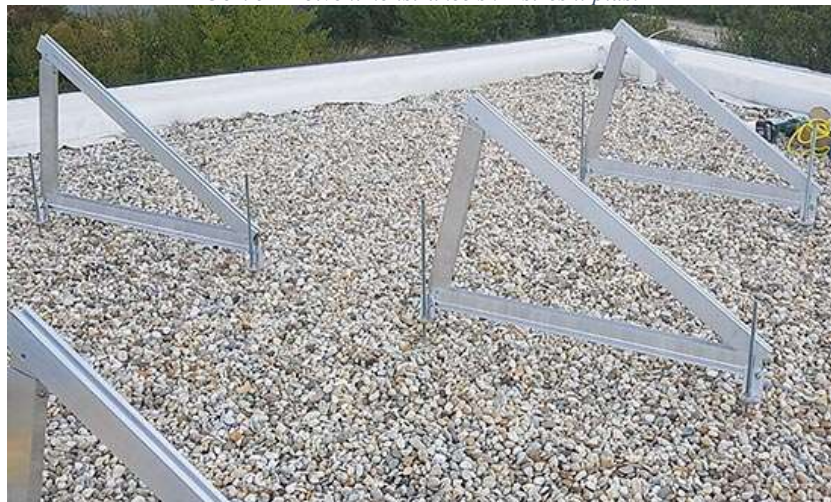
Obr. 5 - Kotvení konstrukce skrz střešní plášť
