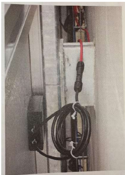
Obr. 18 - Vedení kabelů v provětrávané fasádě
