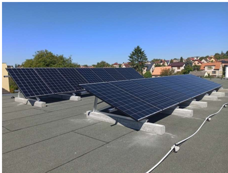
Obr. 6 - Kotvení panelu k zatěžovacím betonovým blokům
