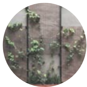
e. zelená stěna u schodiště – popínavé rostliny natažené na perforovaném plechu zábradlí
