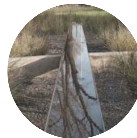
f. vodní prvek z apušťený v náměstí, žlab z patinující oceli, lávky z patinující oceli, umístění roštu pod hladinu – zabezpečení proti pádu
