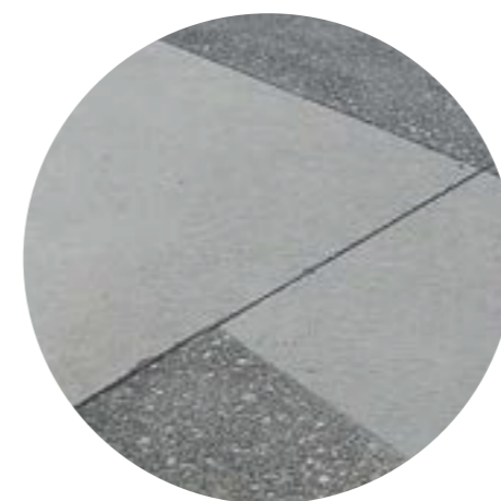
c. betonová exteriernová dlažba, rozhraní dlažeb – dlažba obdél níkového charakteru
