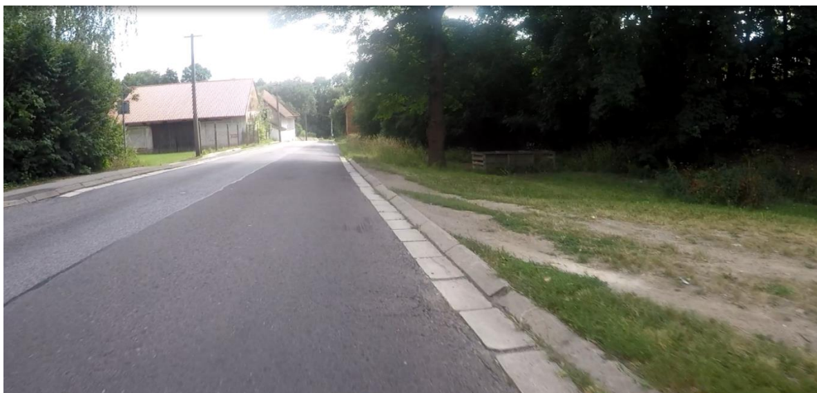
Obrázek č. 4 – pohled na komunikaci
