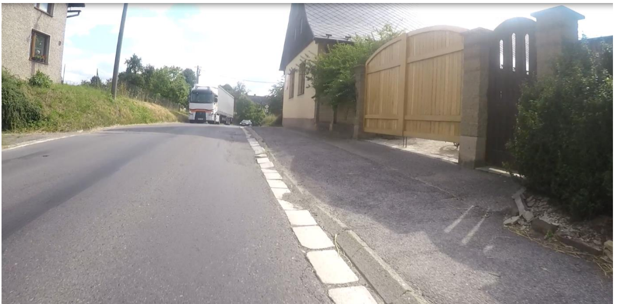
Obrázek č. 8 – pohled na komunikaci
