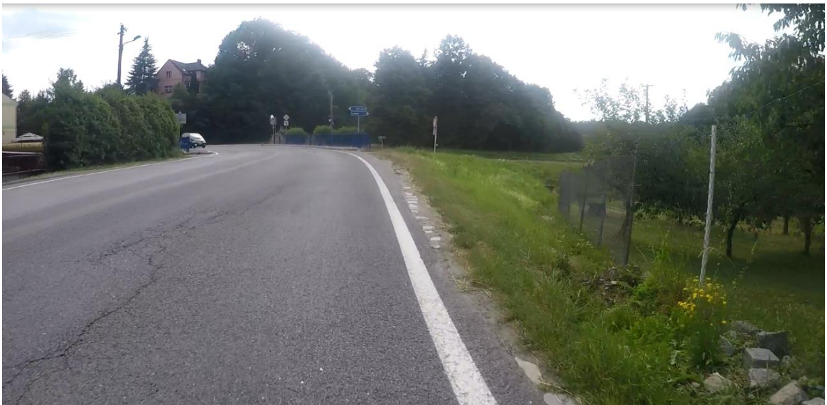
Obrázek č. 12 – pohled na konec úseku
