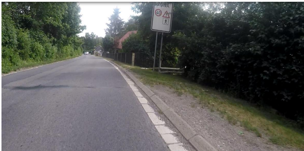
Obrázek č. 1 – pohled na začátku úseku
