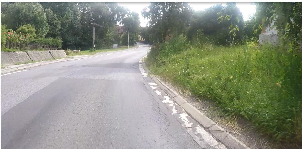
Obrázek č. 6 – pohled na komunikaci
