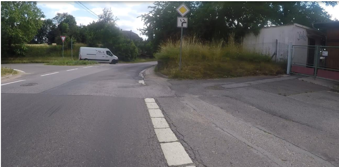
Obrázek č. 10 – pohled na křižovatku
