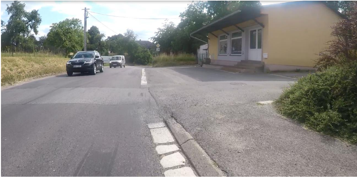
Obrázek č. 9 – pohled na komunikaci
