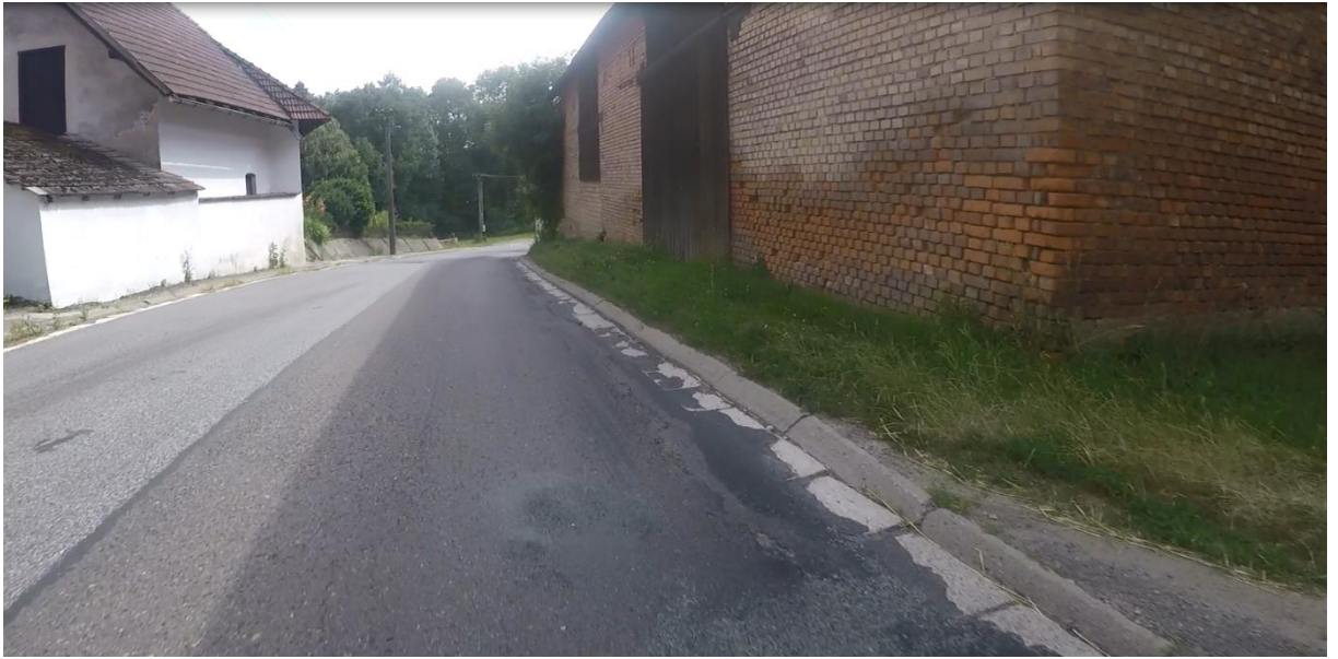
Obrázek č. 5 – pohled na nejužší část chodníku
