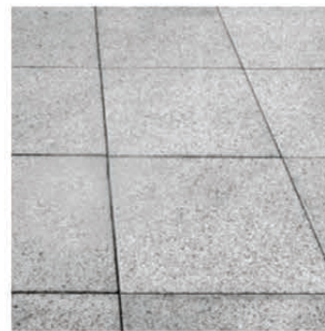
1 - BETONOVÁ DLAŽBA, ROZMĚR 1x1 m
