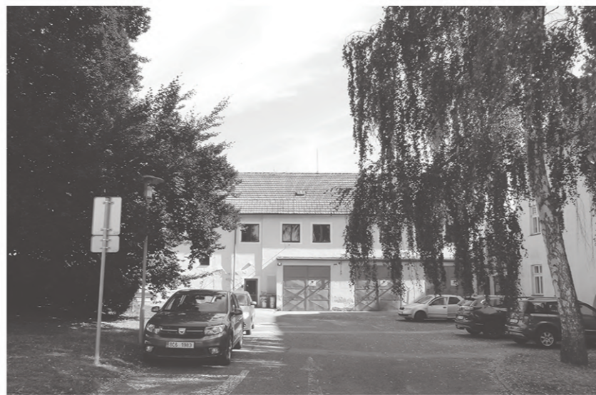
Stávající stav nádvoří
