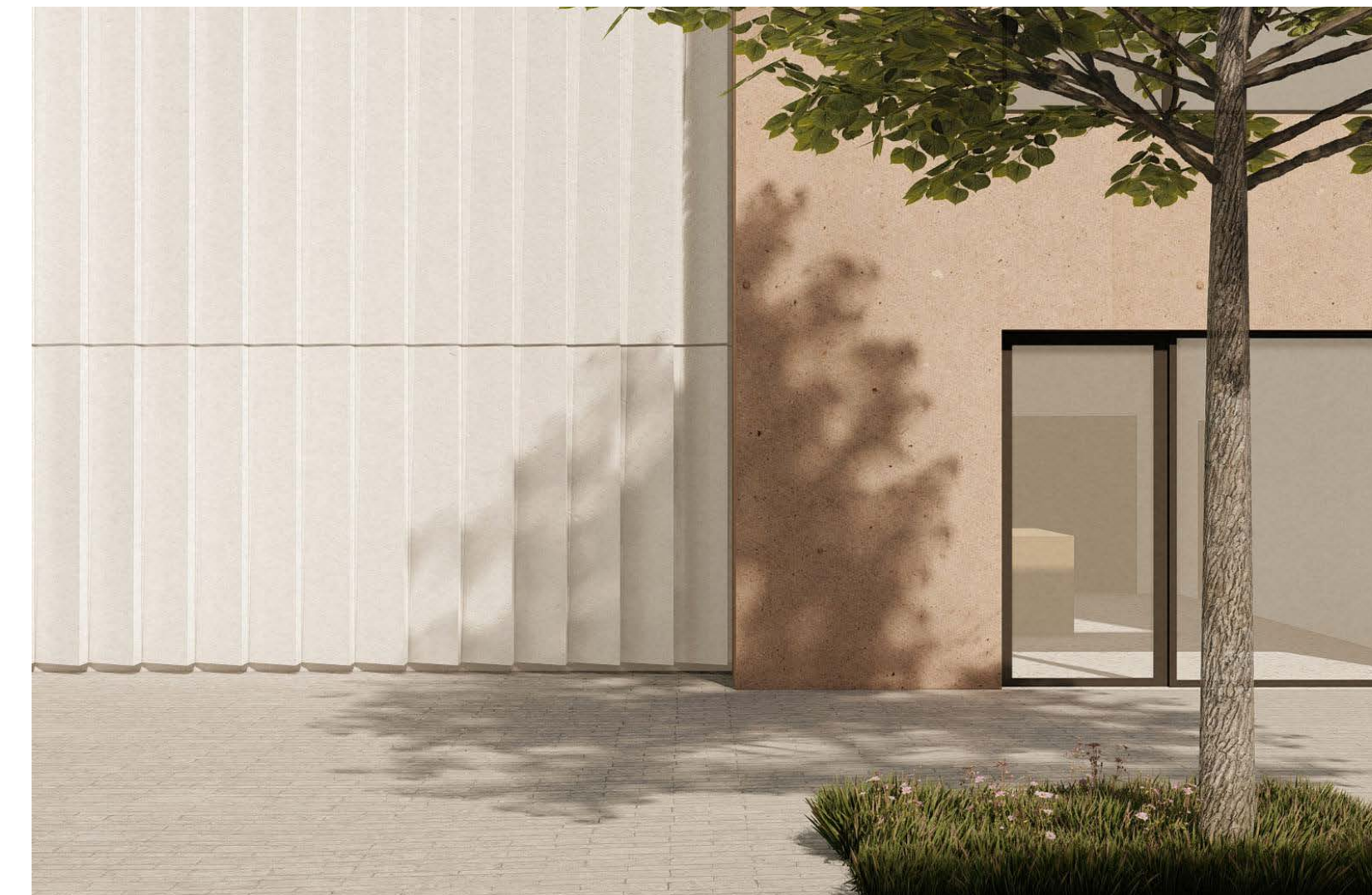
Kombinace bílé pilové fasády a fasády s teracotovou omítkou v detailu.
