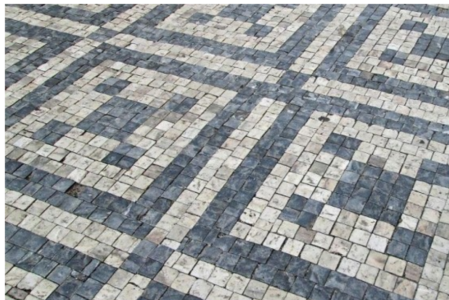
RŮZNÉ VARIANTY PRAŽSKÉ MOZAIKY - zajištění materiálové kompatibility žulové dlažby známé z centra Prahy
