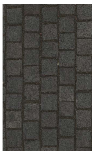
tmavá žulová dlažba 60 x 60 mm na vazbu pro dělicí pruhy
