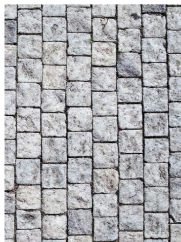
pochozí plocha - světlá žulová dlažba 60 x 60 mm na vazbu
