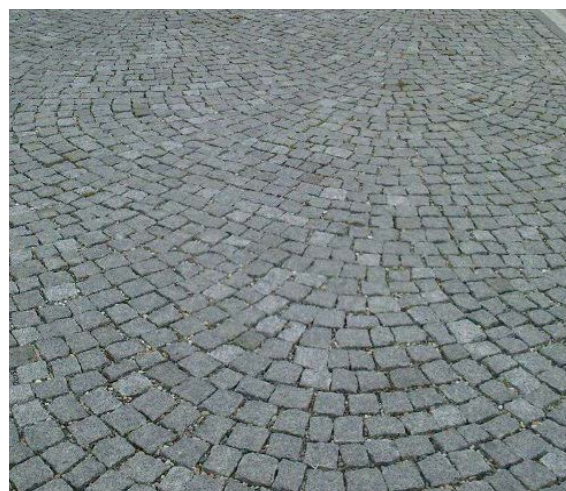
komunikace - žulová dlažba 100 x 100 mm vějířově položená
