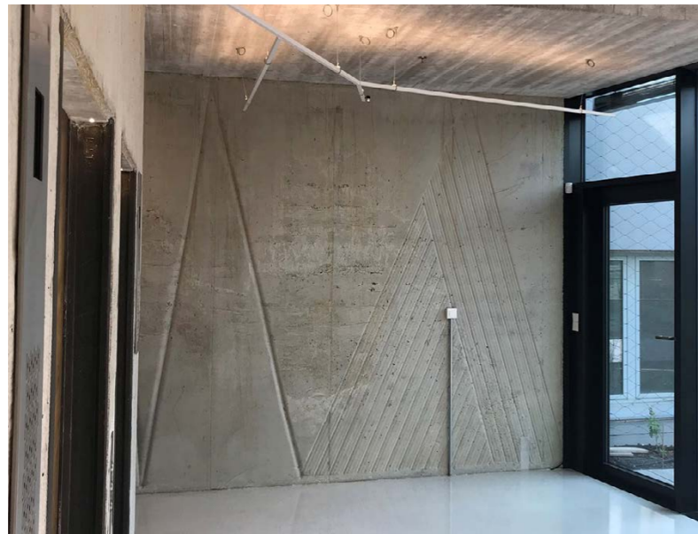
Stěna podél schodiště bude doplněna dílem v podobě otisků do betonu autor: Ing. arch. Stanislav Fiala, Šporkský palác Zdroj: PR článek společnosti TBG Metrostav s.ro
