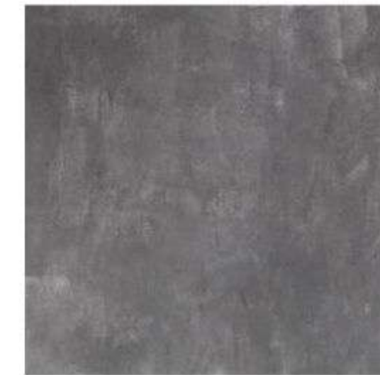
Strop a zadní stěna z pohledového betonu
