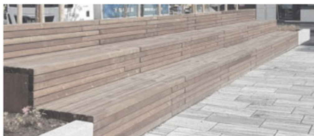
POBITOVÉ SCHODY S DŘEVĚNÝM OBKLADEM
