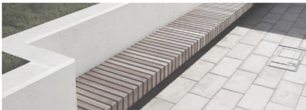
LAVIČKA _ DŘEVĚNÁ NA BETONOVÉ ZDI
