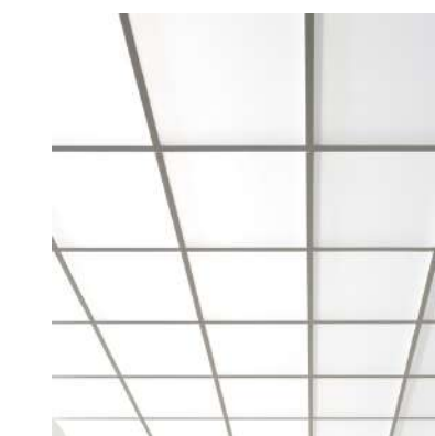
03 DIFUZNÍ OSVĚTLENÍ V KAZETÁCH STROPU
