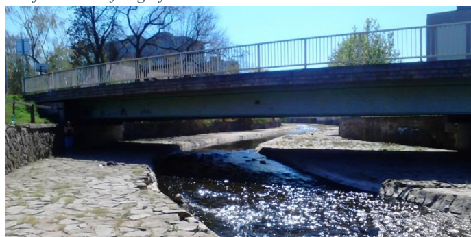
Obrázek 53 – Nízkokapacitní most v ulici Soukenická Zdroj: Autorská fotografie
