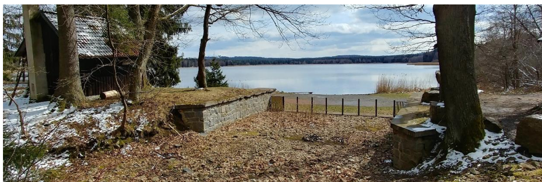
Obrázek 23 – Hořejší Padrťský rybník – pohled od levého bezpečnostního přelivu do zátopy Zdroj: Autorská fotografie
