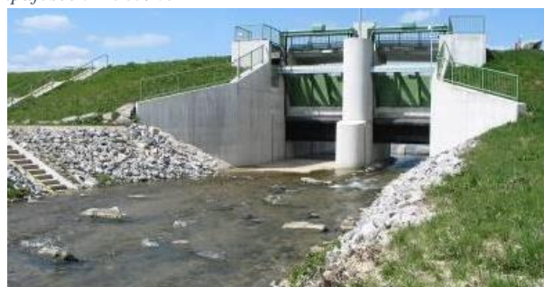
Obrázek 2 – Příklad migračně prostupného výpustního zařízení Zdroj: https://strednicechy.ochranaprirody.cz/res/archive/213/071162.pdf?seek=1585907111
