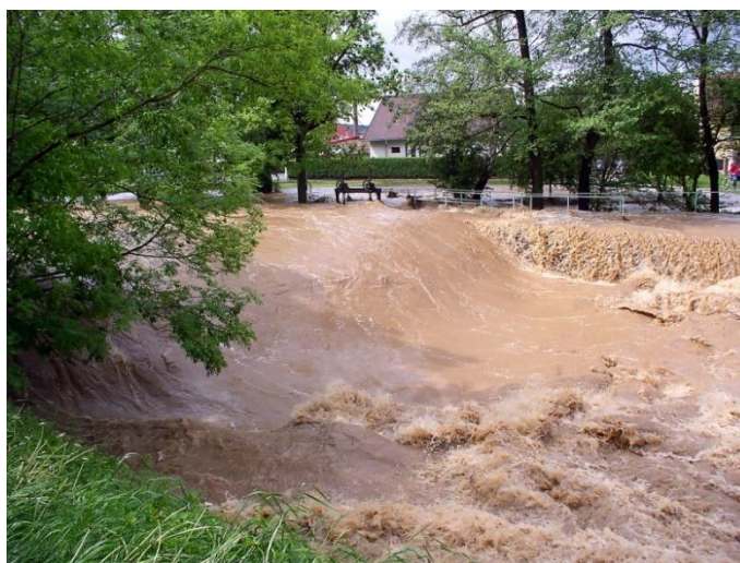
Obrázek 14 – Jez na Prácheň (ř.km 21,043) při povodni v roce 2006
