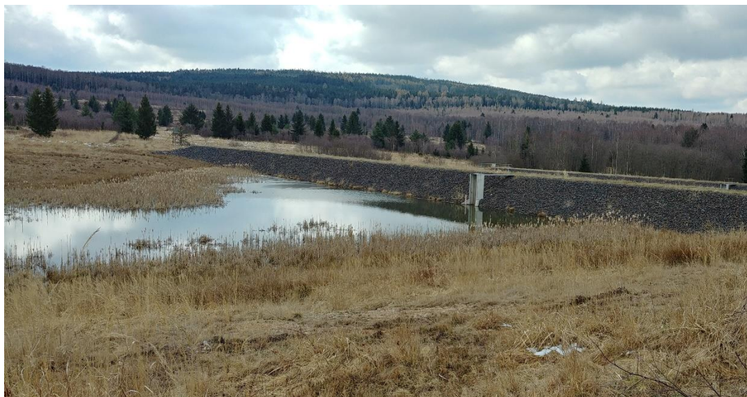
Obrázek 19 – Polosuchá retenční nádrž Bahna I. (v pozadí hrázové těleso nádrže Bahna II.) Zdroj: Autorská fotografie
