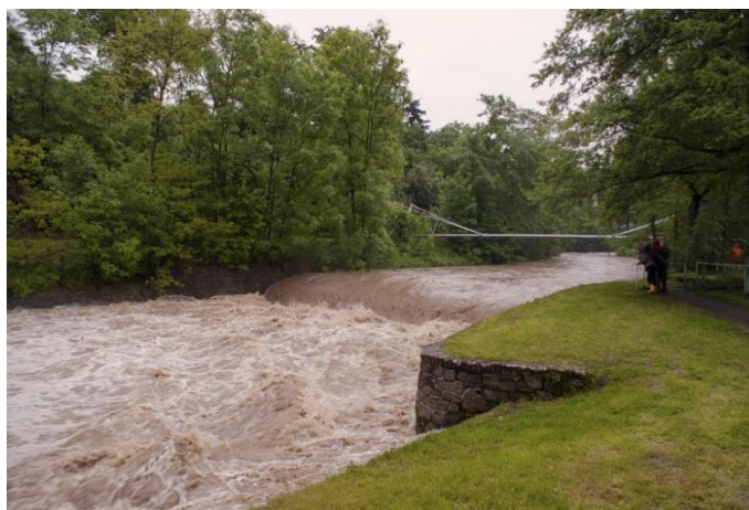
Obrázek 15 – Jez na Prácheň (ř.km 21,043) při povodni v roce 2013
