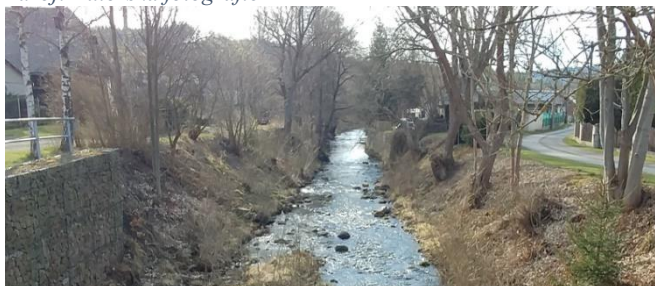
Obrázek 39 – Hlubší koryto opevněné gabionovou zdí, ř. km 34,366 Zdroj: Autorská fotografie
