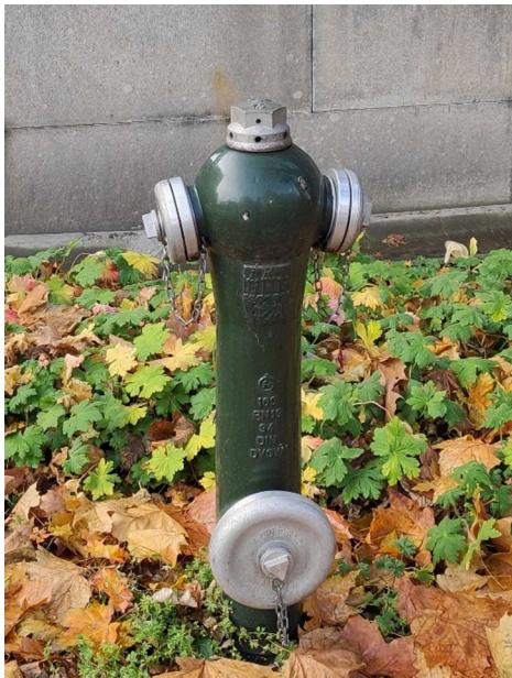
Obrázek 5. Nadzemní hydrant umístěný na travnaté ploše [vlastní foto]
