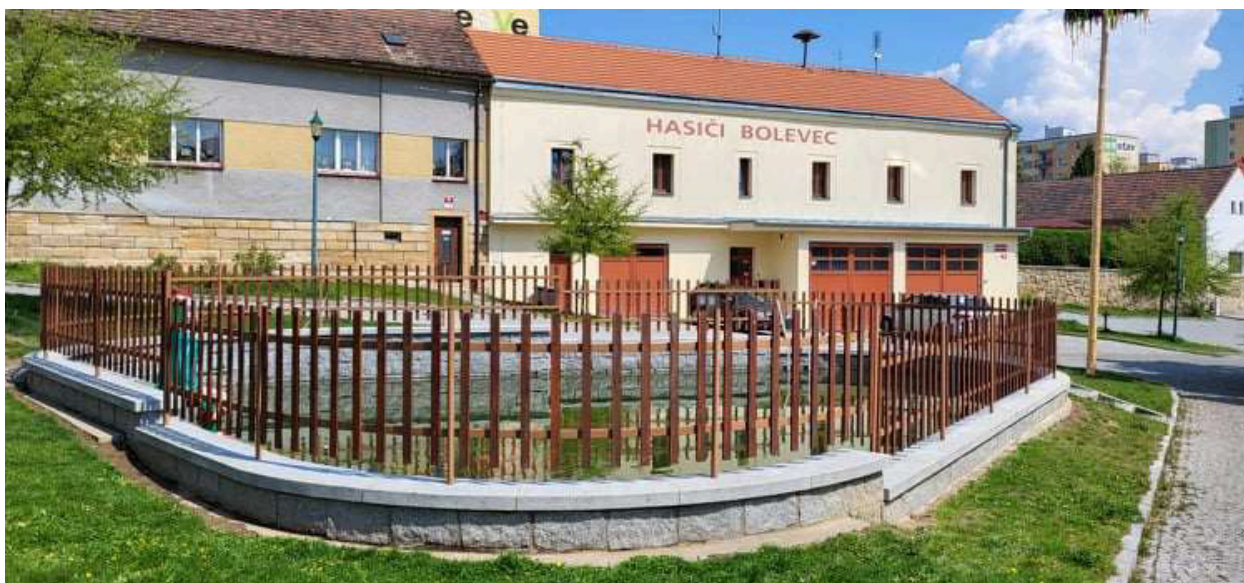
Obrázek 15. – Požární nádrž v Plzni Bolevci, v pozadí se nachází hasičská stanice dobrovolných hasičů [vlastní foto]
