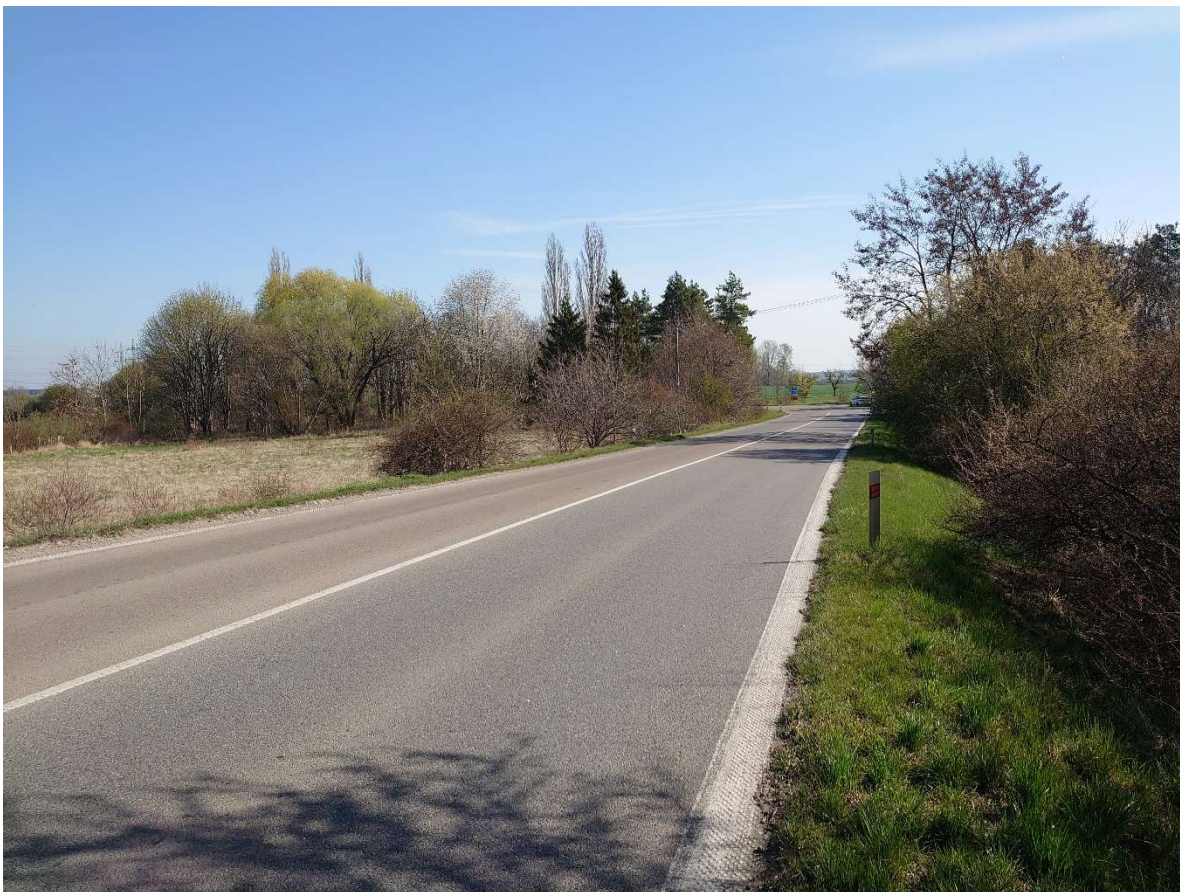
Fotografie č.5 – začátek úseku varianty 0, pohled ve směru staničení
