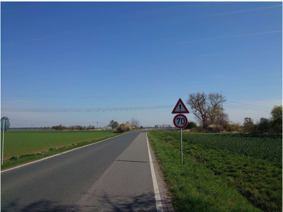
Fotografie č.22 – pohled ve směru staničení stávající silnice II/329, konec úseku varianty 0
