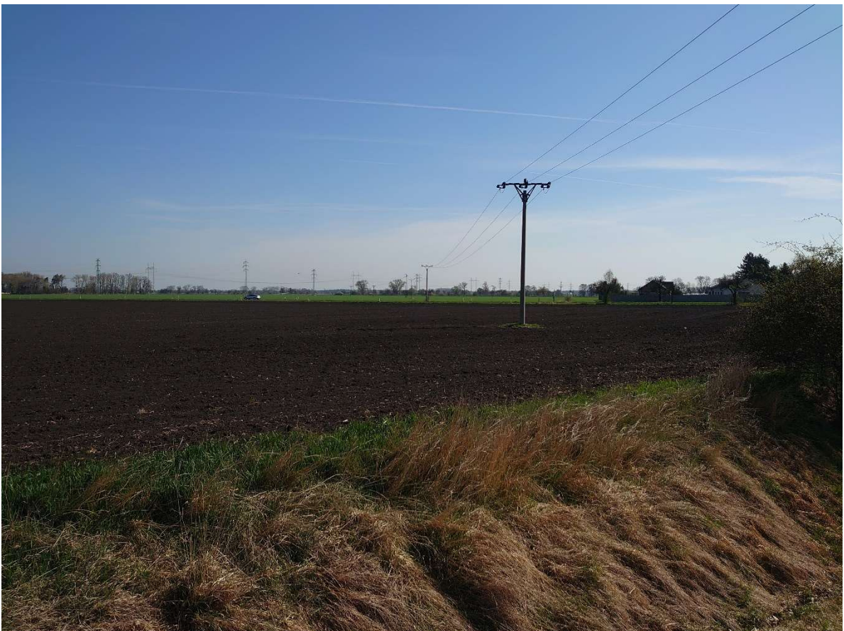
Fotografie č.14 – navrhované místo křížení Pečekého potoka, pohled ve směru staničení
