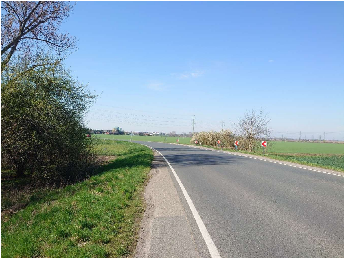
Fotografie č.19 – konec úseku navrhované varianty 0, pohled proti směru staničení
