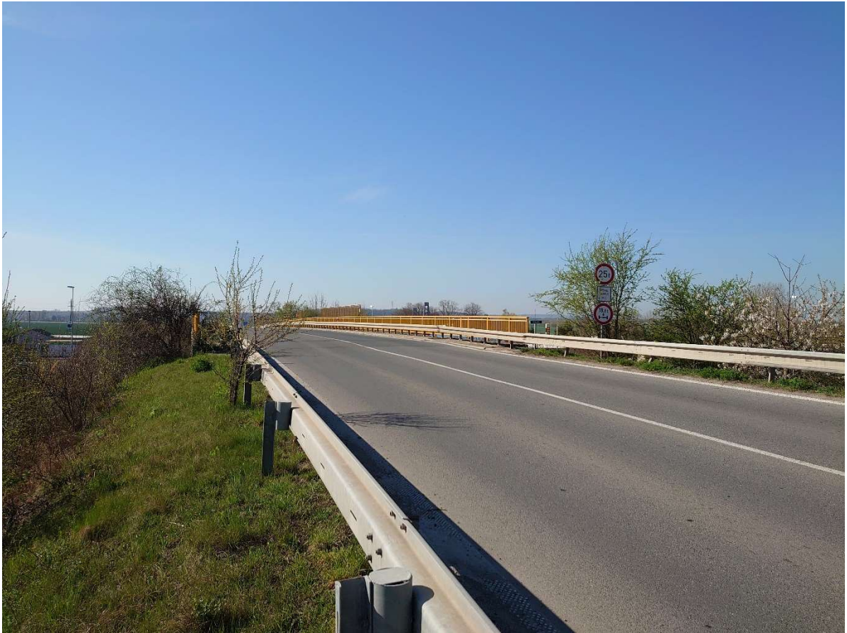
Fotografie č.3 – stávající most přes železnici před začátkem varianty 0, pohled proti směru staničení
