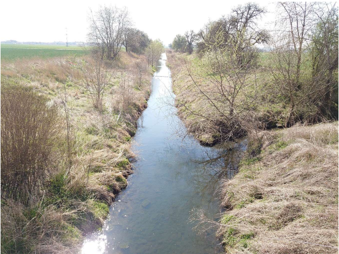
Fotografie č.26 – pohled na koryto Vavříneckého potoka proti směru toku
