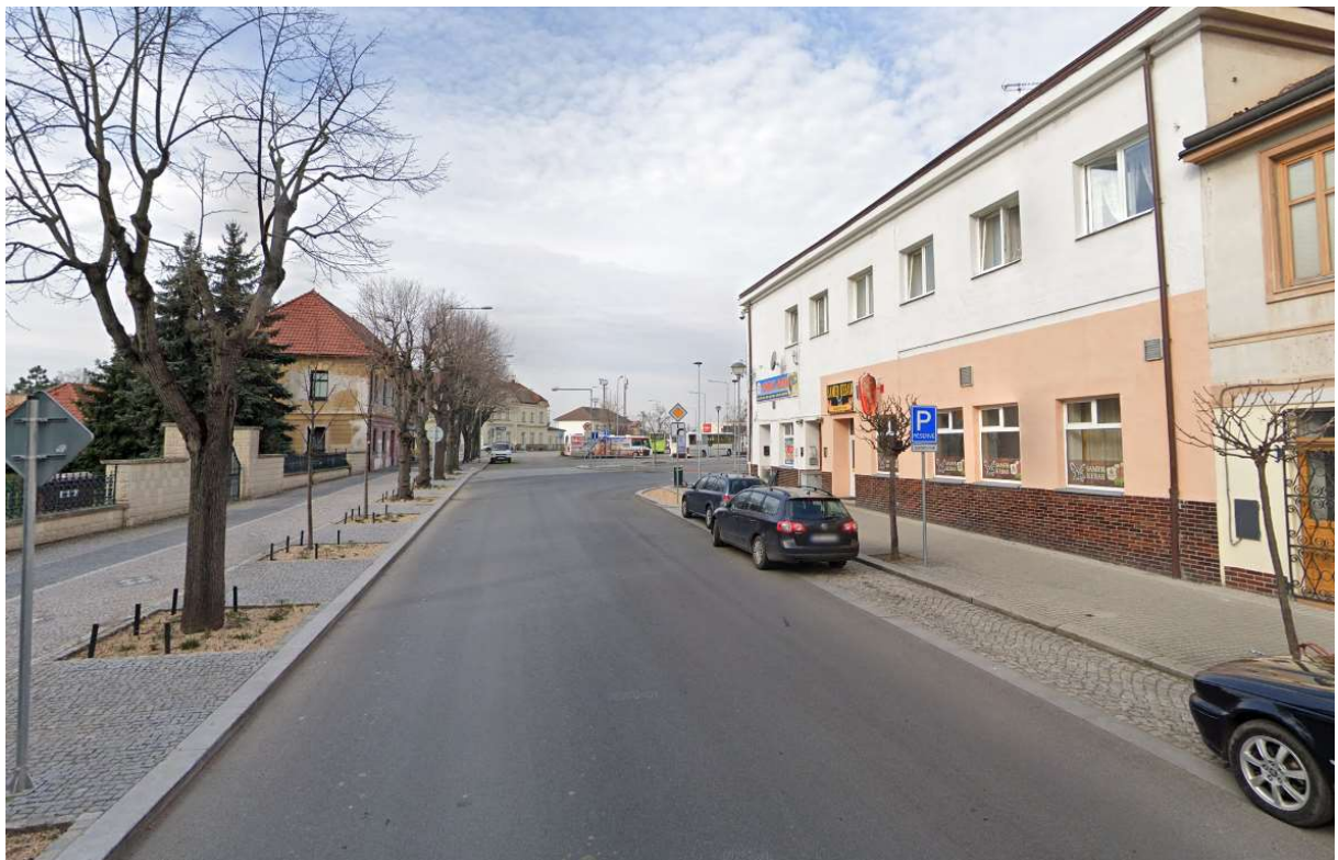
Fotografie č.2 – stávající nevyhovující křižovatka v obci Pečky na trase silnice II/329, ul. Chvalovická x ul. J. A. Komenského, pohled z ul. J. A. Komenského
