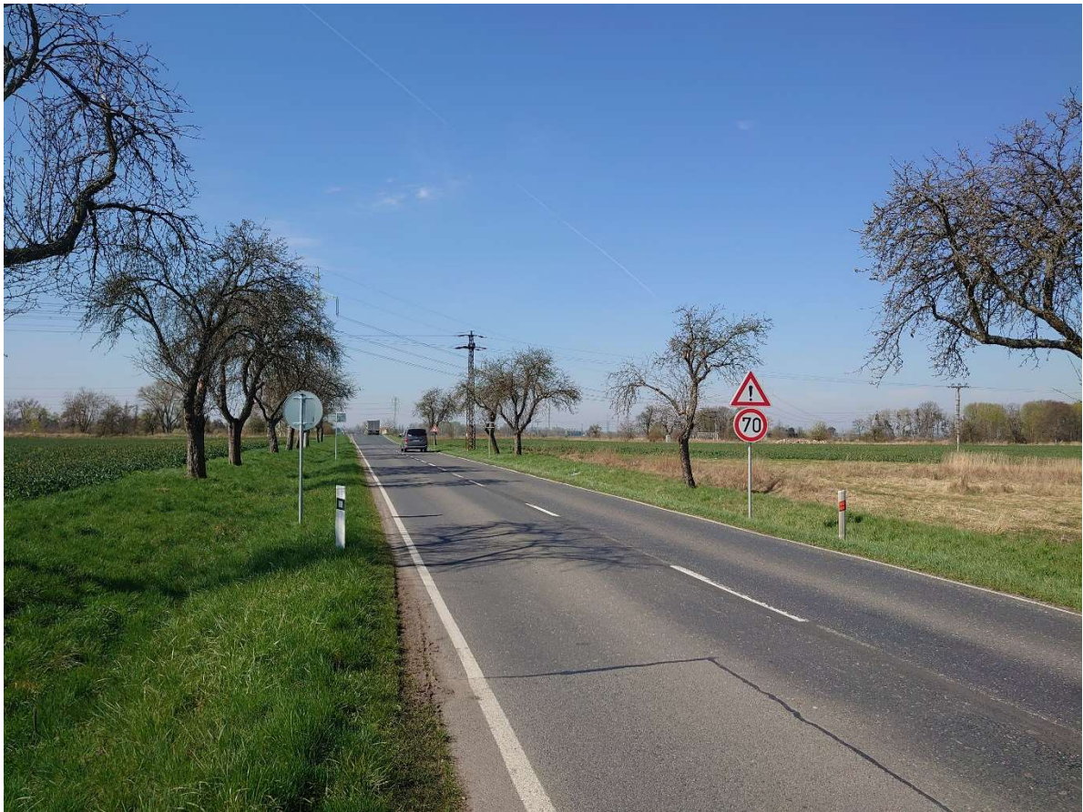
Fotografie č.25 – navazující úsek silnice II/329, pohled proti směru staničení
