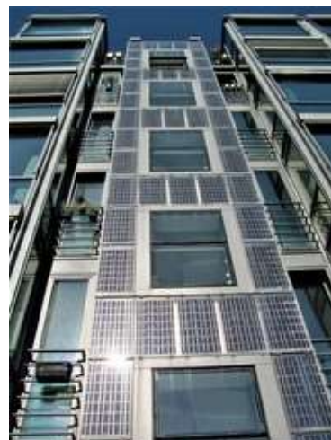
Obrázek 32 a 33: Detaily instalace teplovodních i fotovoltaických panelů na fasádách i balkonech domů. (Foto B. Koč)
