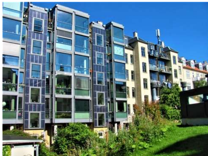
Obrázek 31: Panely solárních systémů na vnitřních fasádách (Foto B. Koč)
