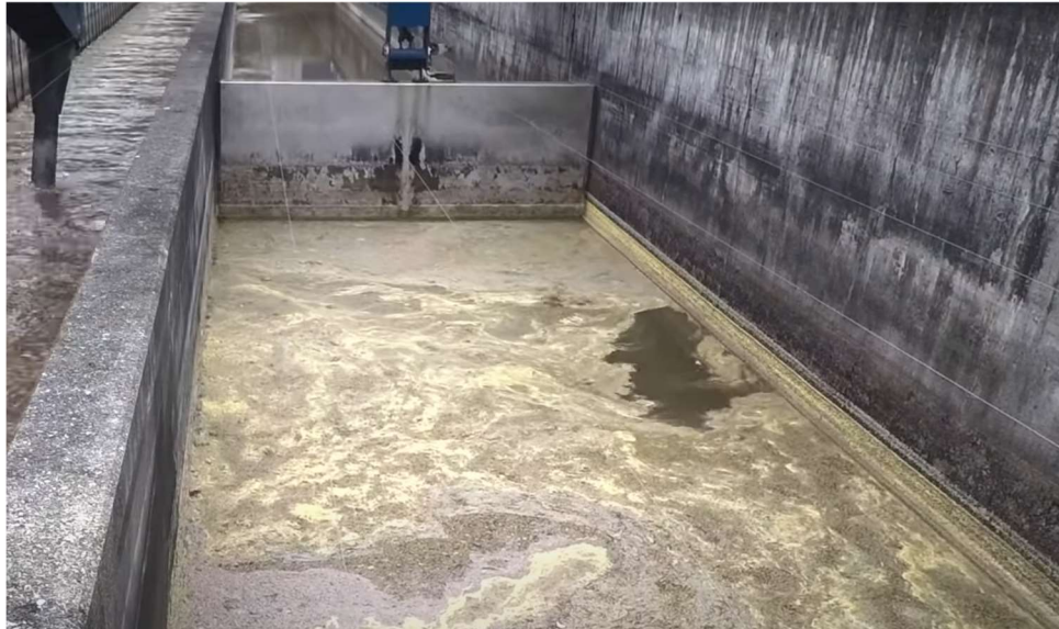
Obrázek 12: Oil and sand trap [18]
