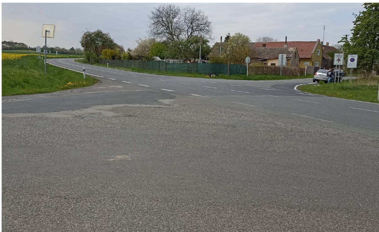
Obrázek 8 :Napojení VAR D, vznik okružní křižovatky I/16 x II/274 x III/2741, Pohled od III/2741
