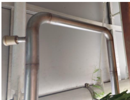
Obrázek 19 – otopný registr ve skleníku
