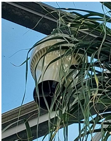
Obrázek 11 – diagonální ventilátor bez směrovací výustě vertikálně zavěšený
