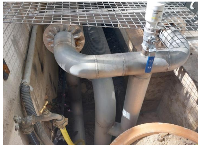
Obrázek 25 – otopný registr v hlavním skleníku
