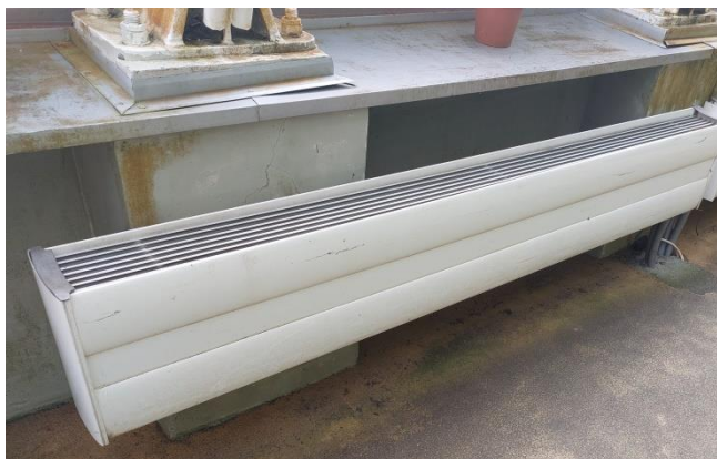
Obrázek 18 – deskové otopné těleso
