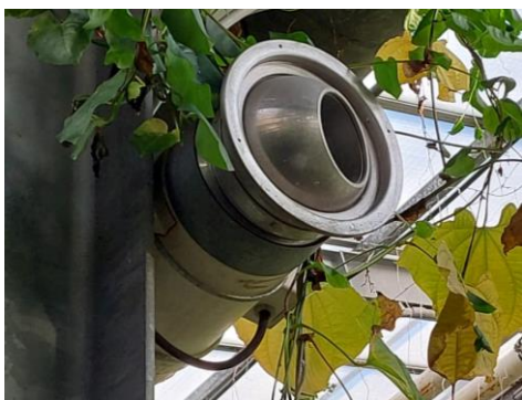
Obrázek 11 – diagonální ventilátor bez směrovací výustě vertikálně zavěšený
