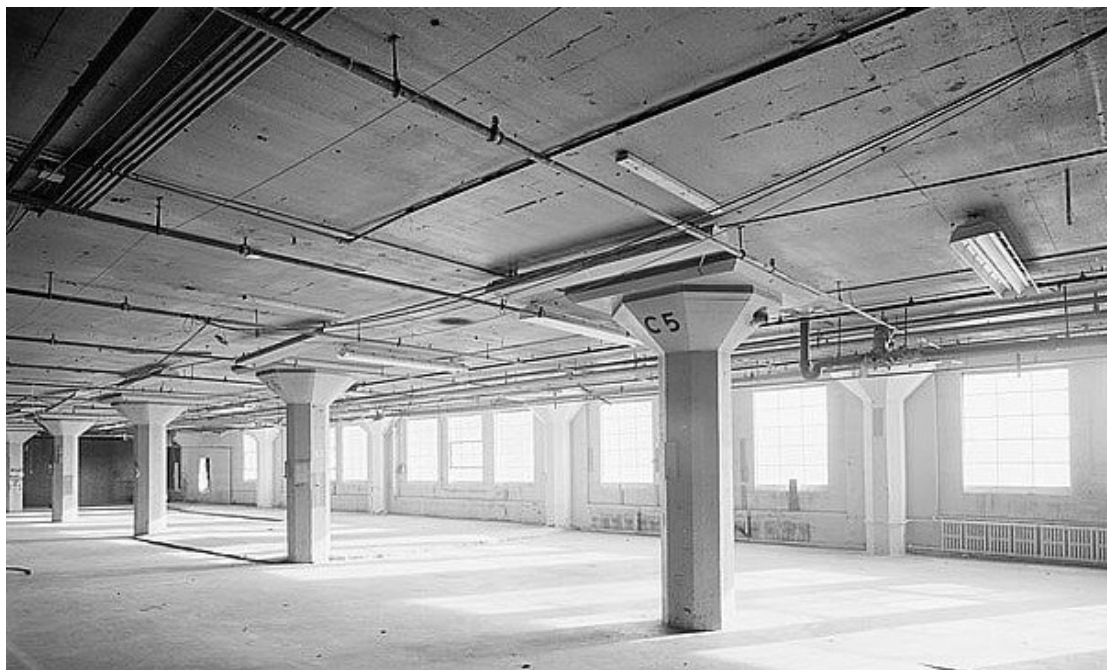
Obrázek 1 – Příklad lokálně podepřené desky [2]
