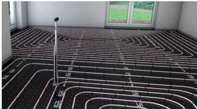
Obr. 16 Příklad provedení podlahového vytápění – izolační desky, trubka upevněná háčky, otopný had ve tvaru plošné spirály
