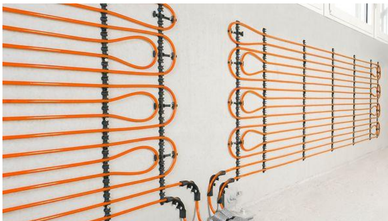
Obr. 17 Příklad provedení stěnového vytápění – mokrý způsob montáže
