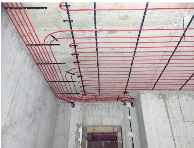
Obr. 18 Příklad provedení stropního vytápění – mokrý způsob montáže
