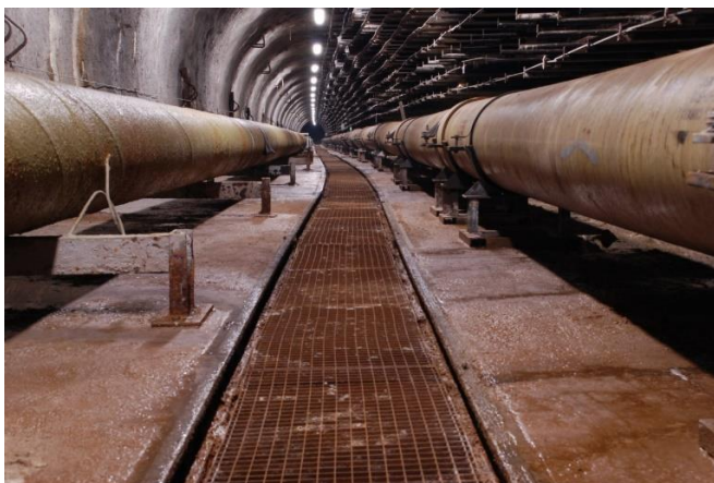
Obr. 5 Příklad provedení kolektoru – Brno
