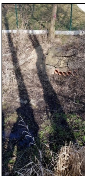
Obrázek 25 – Druhý svod dešťové kanalizace koupaliště Pilař (0,375 ř. km)
