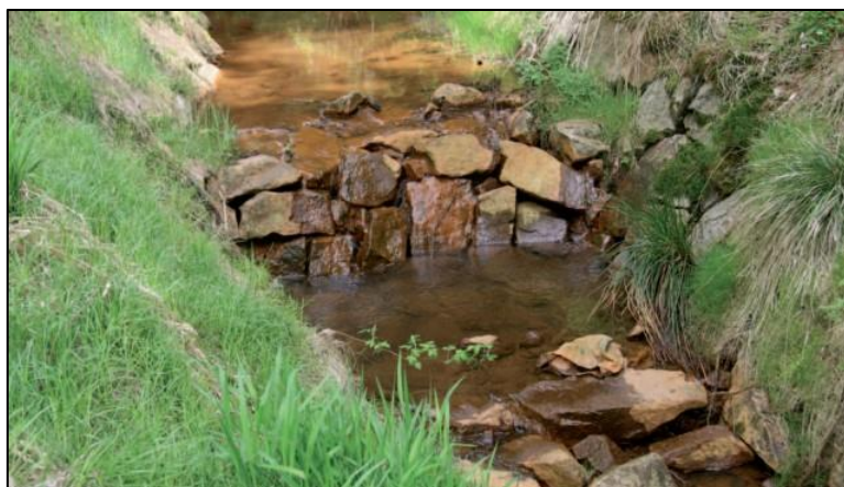
Obrázek 20 – Příklad kamenného prahu ve dně pro úpravu podélného sklonu [6]
