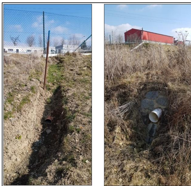
Obrázek 24 – Svod dešťové kanalizace a bezpečnostního přepadu koupaliště Pilař (0,428 ř. km)
