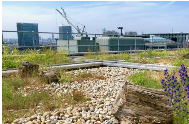
Obrázek 15 Použití štěrku na biodiverzní střeše, zdroj: The GRO green roof code
