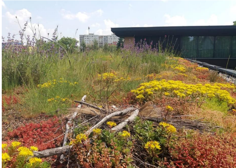
Obrázek 19 Mrtvé dřevo na biodiverzní střeše, zdroj: https://www.greenville.cz/biodiverzni-strecha.html
