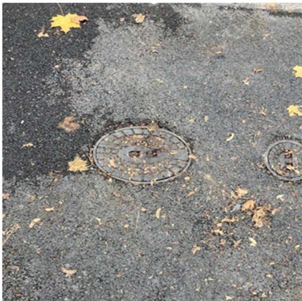
Obrázek č. 5: Podzemní hydrant [Vlastní foto]
