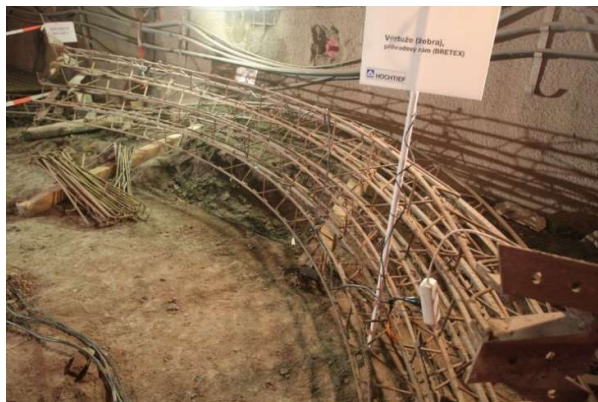
Obrázek 1 Příhradové výztužné rámy „Bretex“ (37)
