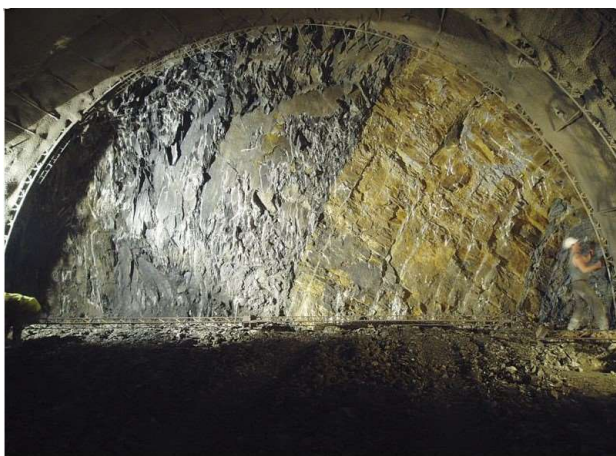
Obrázek 6 Rozhraní křemenců a břidlic na čelbě Vítkovských tunelů (27)
