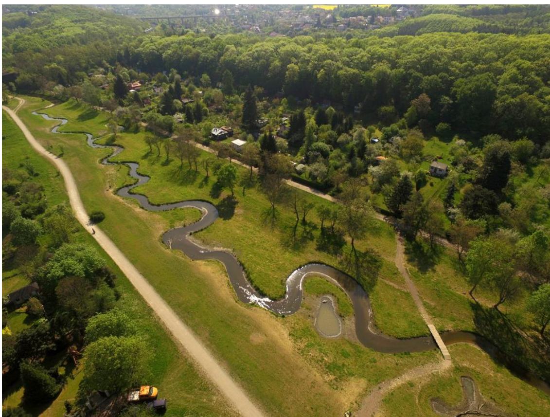
Obrázek 8: Vytvoření nového meandrující koryta v původní nivě [19]
