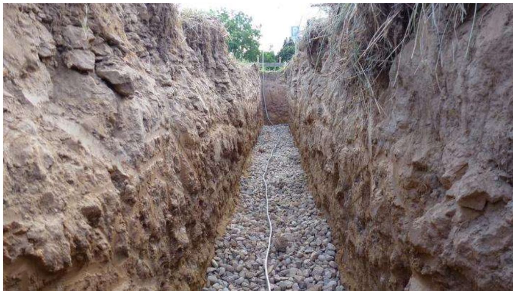
Obr. 22 Vrstva štěrkopískového polštáře pod budoucími pasy [10]
