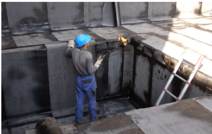
Obr. 29 Příklad hydroizolace spodní stavby černou vanou [17]
