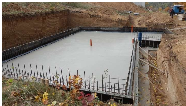
Obr. 30 Příklad hydroizolace spodní stavby bílou vanou [18]
