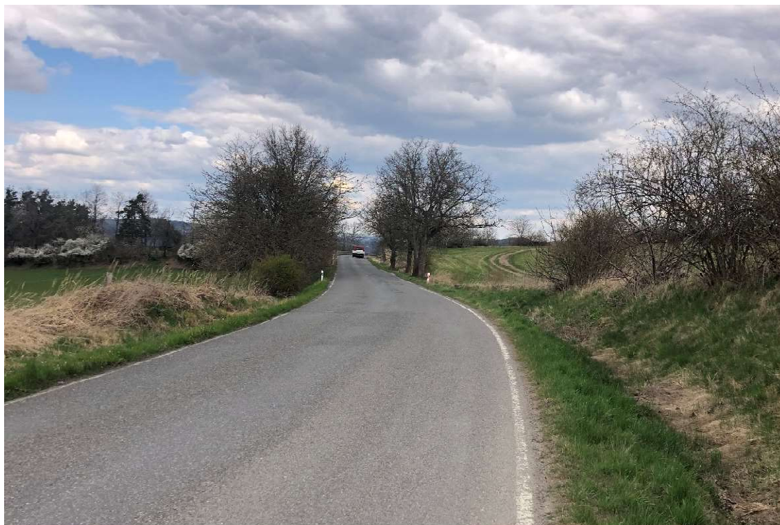
Obr. 3 – Silnice II/106 vedoucí z obce Krňany směr Hostěradice
