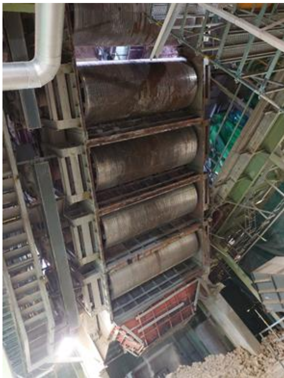
Obrázok 8: Pohľad na demontáž valcového roštu (zdroj: www.psas.cz )
