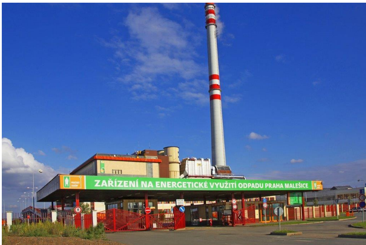
Obrázok 7: Zariadenie na energetické využitie odpadu Praha Malešice (zdroj: www.cez.cz )
