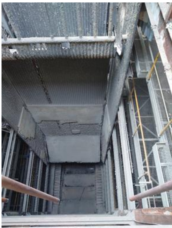
Obrázok 9: Pohľad cez K3 – bývalý prvý ťah; úplne dole – valcový rošt (zdroj: www.psas.cz )
