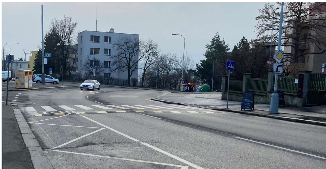
Obrázek 5 – Nevyhovující přechod v ústí ulice Peroutkova, zdroj: vlastní
