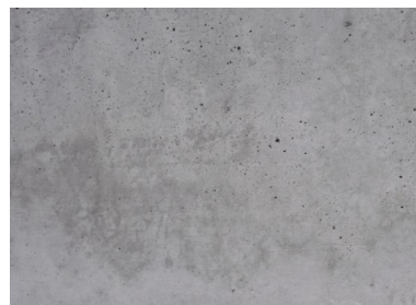
pohledový beton na stropě
