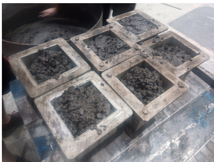
Obrázek 14: Betonáž první sady krychlí
