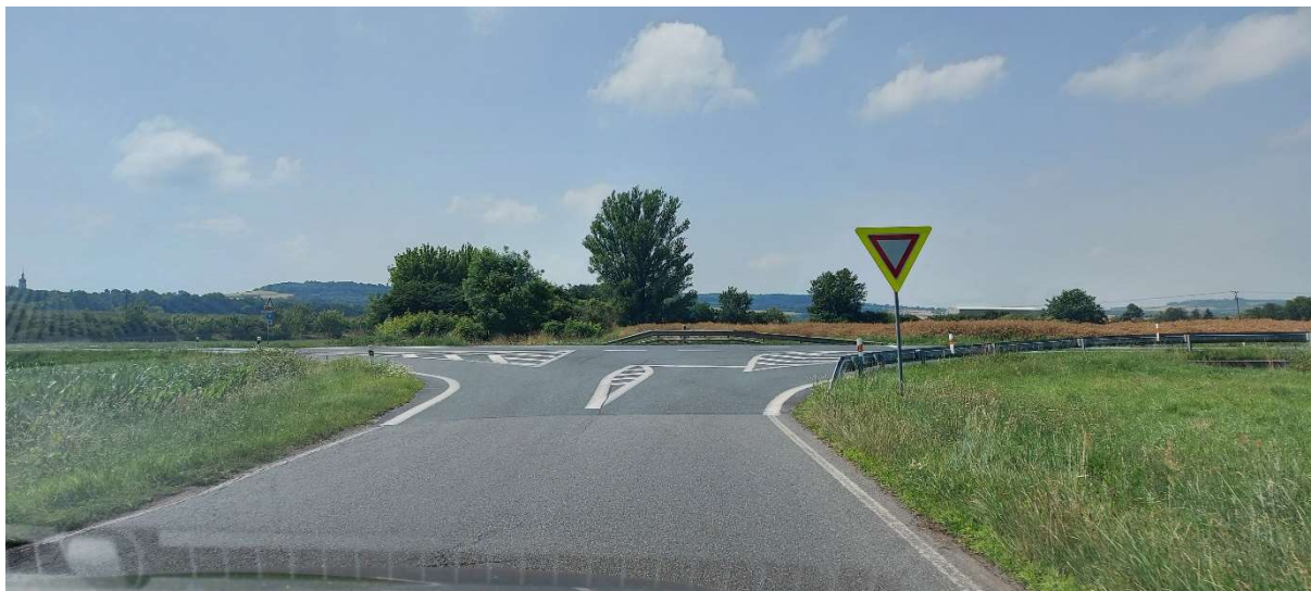
Obrázek 4 – pohled z vedlejší na stykovou křižovatku I/38 x III/3277
