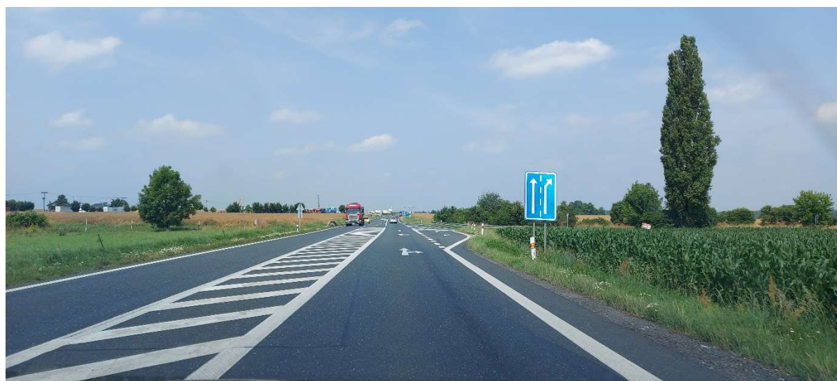
Obrázek 5 – pohled z hlavní na stykovou křižovatku I/38 x III/3277 (proti směru staničení)
