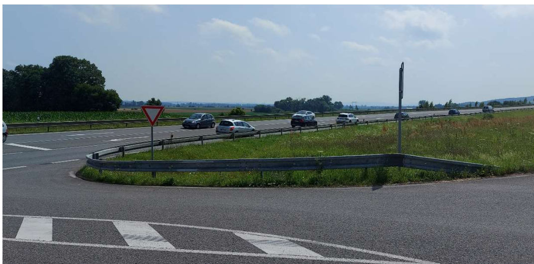
Obrázek 2 – od areálu ve směru staničení
