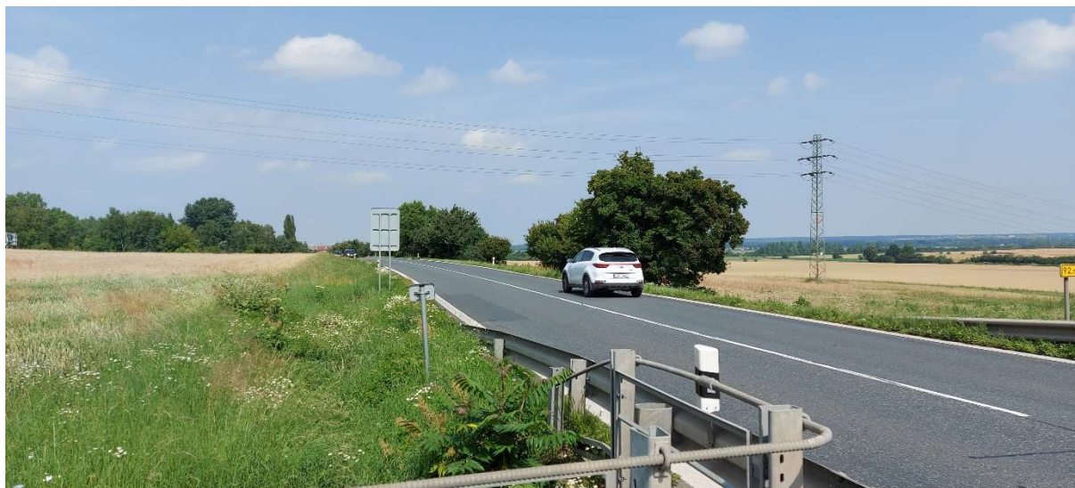
Obrázek 11 – pohled od Hlízova (proti směru staničení)
