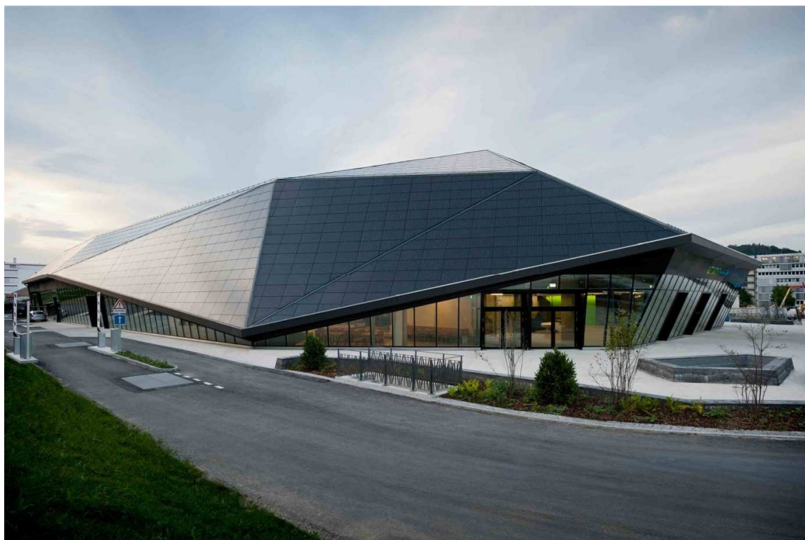
Obrázek 2 Pozitivní příklad použití (integrování) fotovoltaických panelů: Umwelt Arena, Spretenbach, Švýcarsko, 2012, Rene Schmidt Architekten; zdroj: https://www.archdaily.com/285637/umwelt-arena-rene-schmid-architekten
