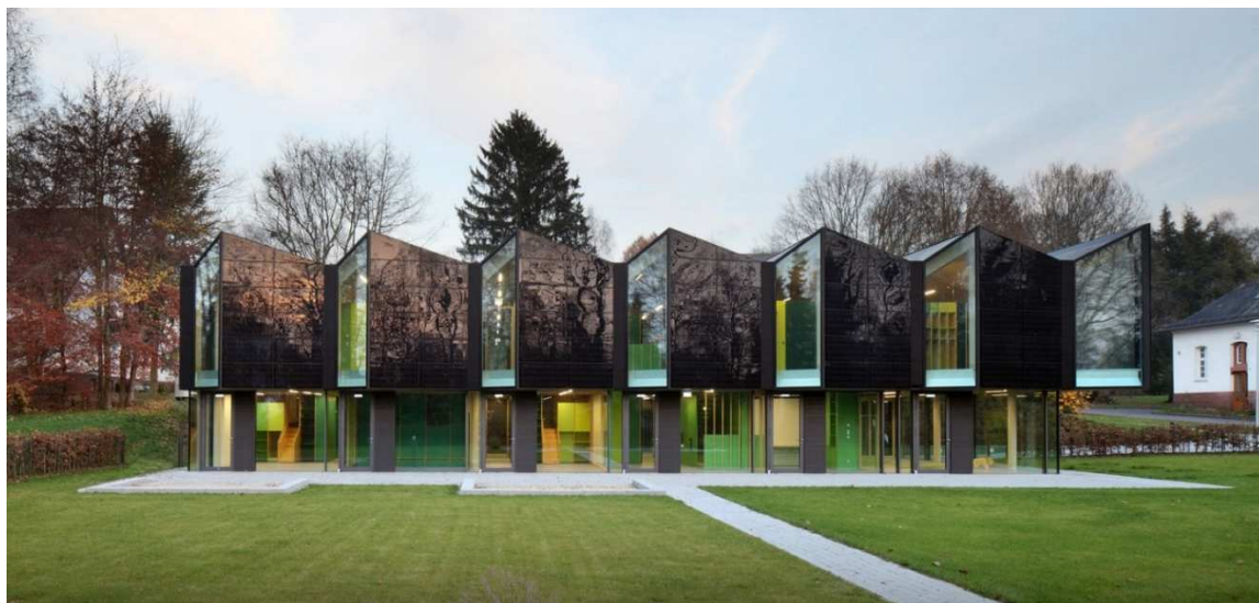
Obrázek 35 Daycare centre, Marburg, Německo, 2014, Opus Architekten Použití křemíkových monokrystalických článků – 81 m 2 na fasádě + 304 m 2 na střeše Zdroj: https://www.solarpowereurope.org/2019/06/19/
