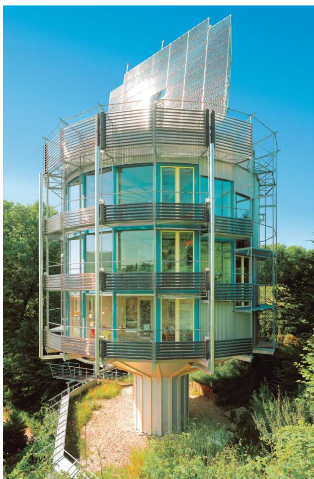
Obrázek 6 Heliotrope, Freiburg, 1994, Rolf Disch Solar Architektur. Zdroj: http://www.rolfdisch.de
