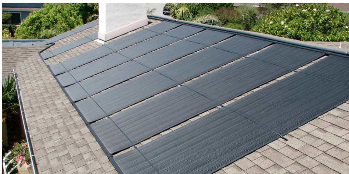
Obrázek 18 Plochý nekrytý kolektor pro vytápění bazénu
