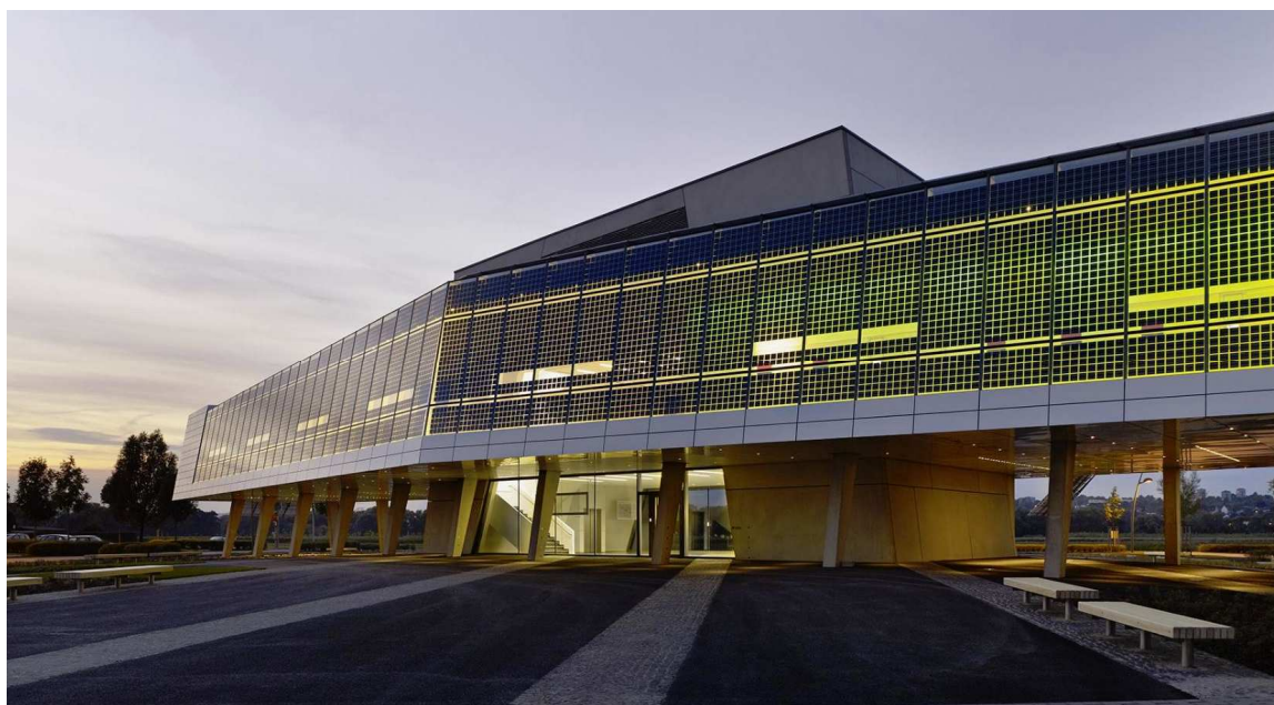
Obrázek 36 Solar Academy, Niestetal, Německo, 2010, HHS Architekten Použití monokrystalických křemíkových článků přímo na oknech budovy – 310 m 2 fasády Zdroj: https://www.hhs.ag/projects.html?projekt=solar-academy&typologie=
