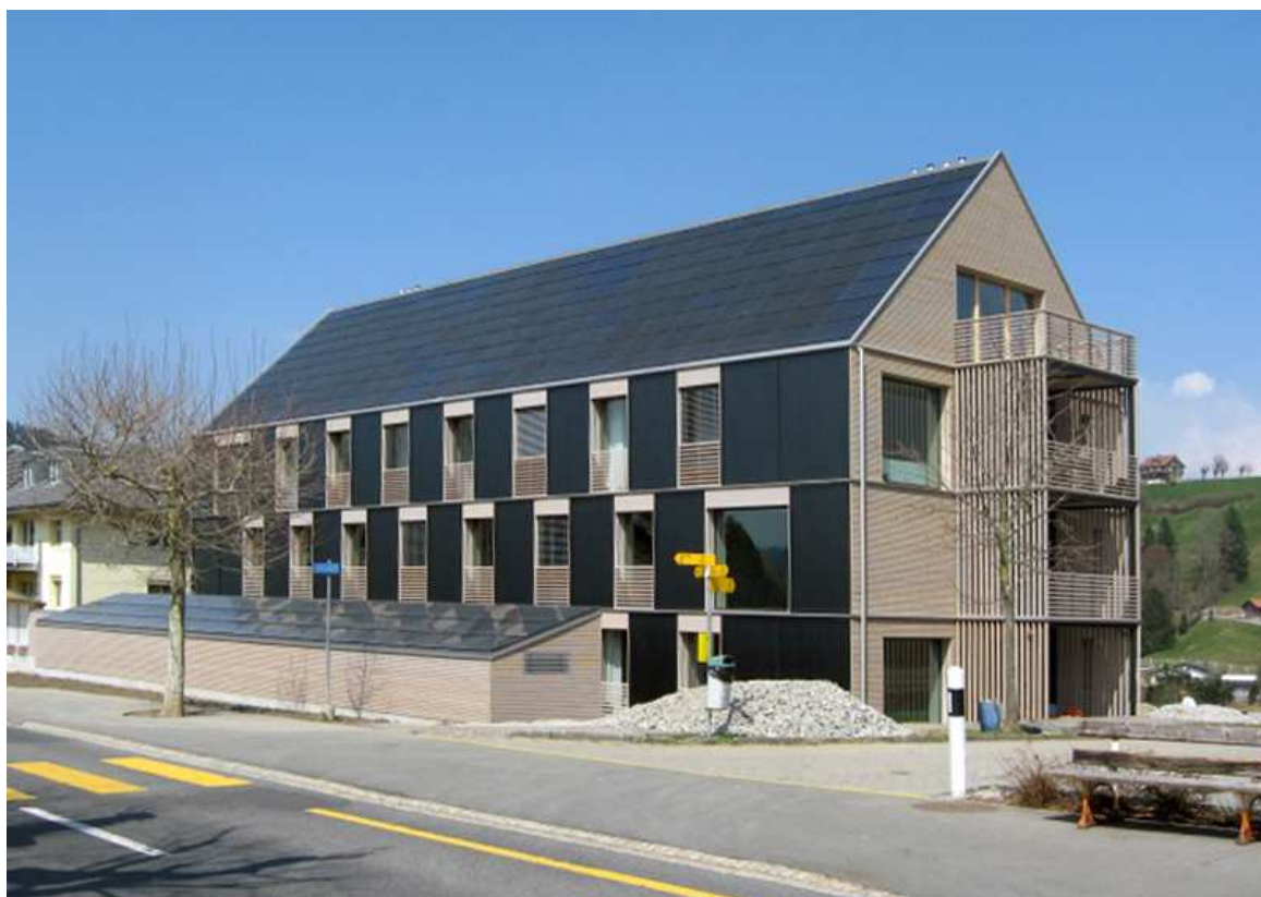
Obrázek 16 Bytový dům, Bennau, Švýcarsko, 2009, Grab Architekten Použití integrovaných FV panelů na střeše a integrovaných FV kolektorů na fasádě Zdroj: https://www.solarpowereurope.org/2019/06/19/
