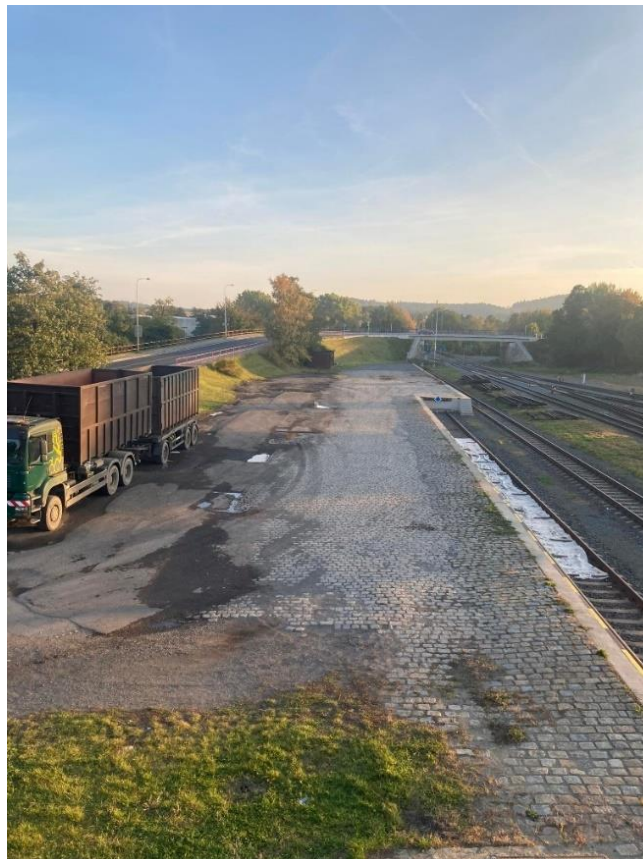
Obrázek 29 - nákladová rampa na železniční stanici Krnov
