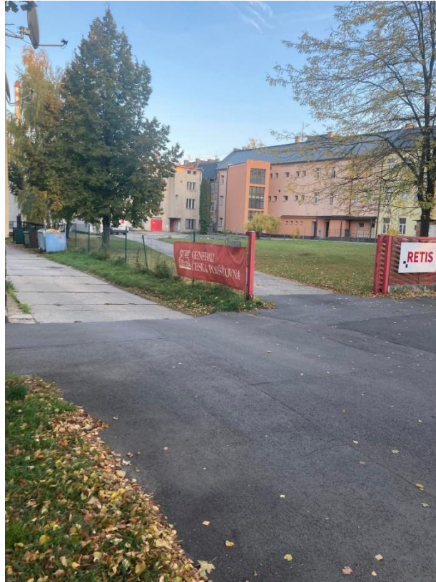
Obrázek 22 - vjezdy do objektů na východní straně přednádražního prostoru
