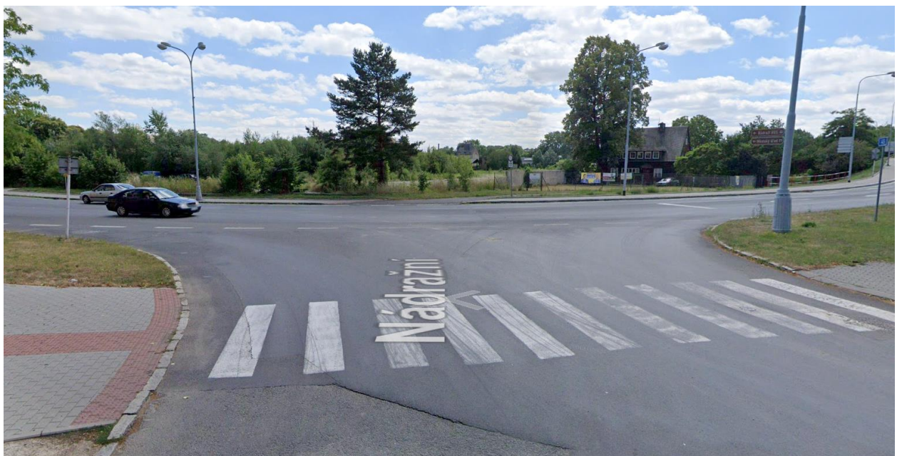
Obrázek 18 - současný stav křižovatky Revoluční x Nádražní (pohled od železniční stanice) [12]
