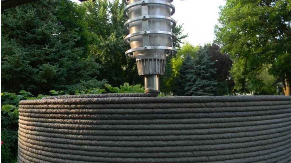
Obrázek 27 3D tisk z cementových malt [18]
