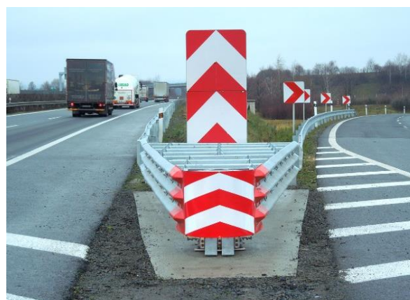
Obrázek 14 – Vodící tlumič nárazu. [16]
