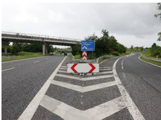
Obrázek 70 – Společné umístění SDZ IS 4c, DZ Z 4c a IS 7a v rozštěpu křižovatky. (MÚK I/13 x I/27)
