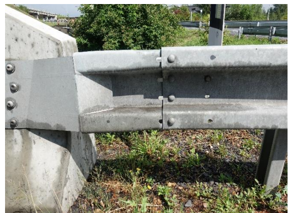
Obrázek 64 – Detailní pohled na absenci spojovacího materiálu (propojovacích šroubů). (MÚK I/13 x I/27)
