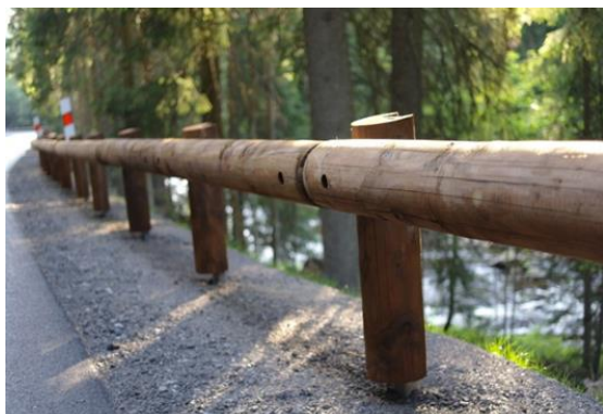
Obrázek 9 – Detailní pohled na dřevocelové svodidlo. [14]
