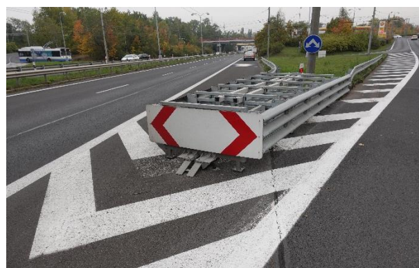
Obrázek 36 – Pohled na tlumič nárazu nacházející se v prostoru bezpečné zóny PK.
