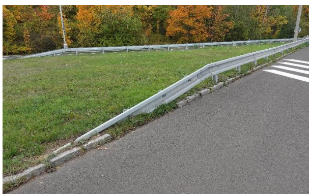
Obrázek 37 – Pohled na ukončení ocelového svodidla na hlavní silnici.
