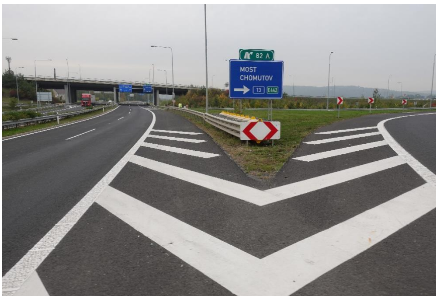
Obrázek 19 – Správné umístění tlumiče nárazu mimo dopravní stín. (MŮK Chomutov I/7 x I/13)
