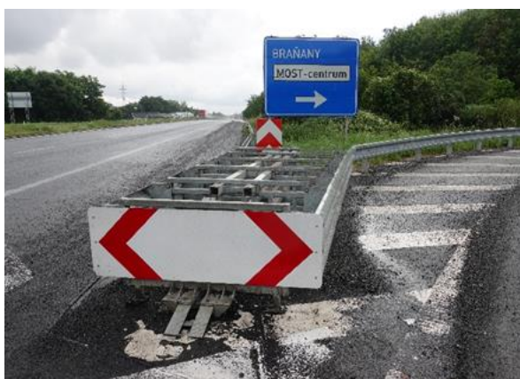
Obrázek 13 – Vodící tlumič nárazu (MÚK I/13 x MK Rudolická).
