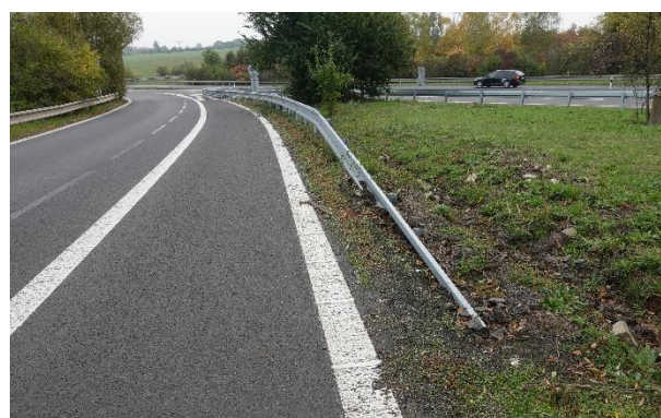
Obrázek 47 – Pohled na ukončení ocelového svodidla v místě vedlejší větve.
