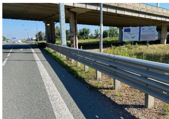
Obrázek 4 – Ocelové svodidlo JSA-AM-1/H2.
