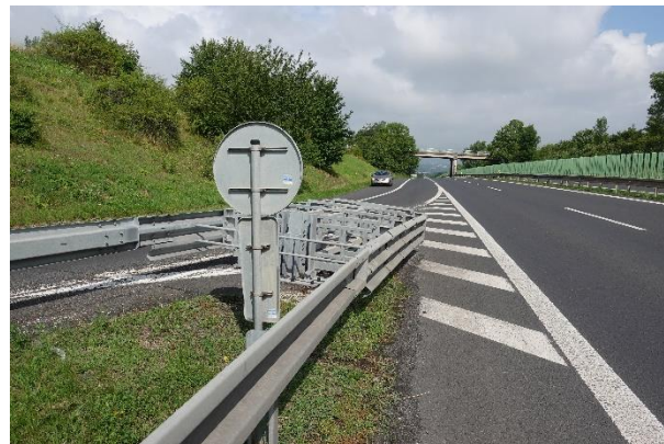
Obrázek 52 – Výhled z místa tlumiče nárazu ve směru proti příjezdu dopravního proudu.
