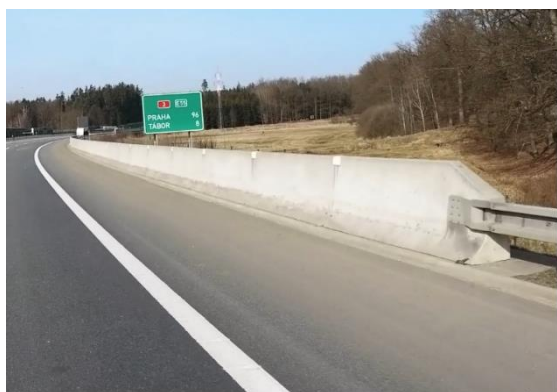
Obrázek 7 – Jednostranné betonové svodidlo.
