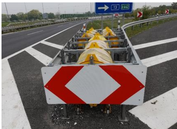
Obrázek 11 – Tlumič nárazu s pneumatickými válci. (MÚK Chomutov I/7 x I/13)
