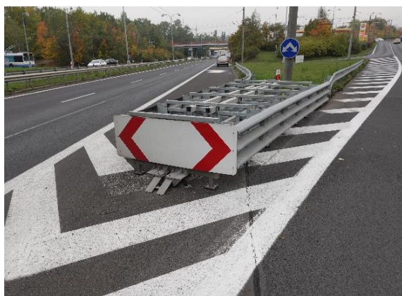
Obrázek 65 – Tlumič nárazu před pevnou překážkou. (MÚK I/13 x MK Březenecká)
