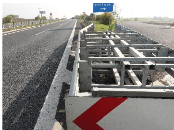
Obrázek 73 – Neopodstatněné umístění tlumiče nárazu ochraňující pouze vzrostlou zeleň. (MÚK Malhostice I/63 SMV x III/253 36)
