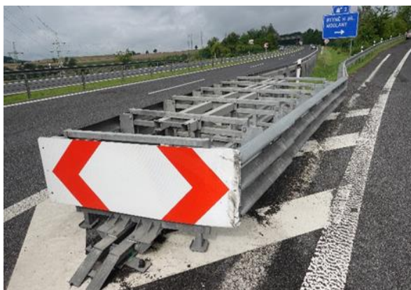
Obrázek 59 – Umístění tlumiče nárazu do dopravního stínu. (MÚK Malhostice I/63 SMV x III/253 52)
