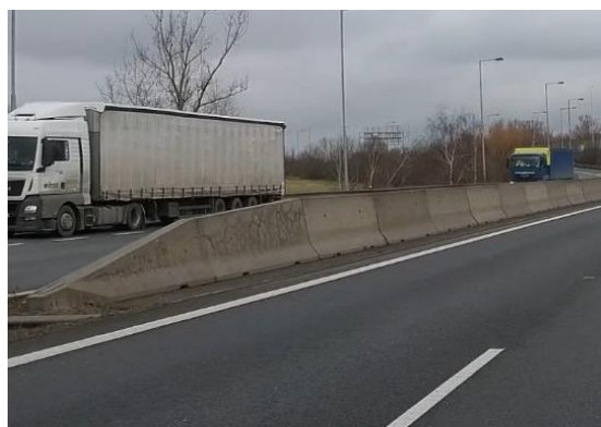
Obrázek 8 – Oboustranné betonové svodidlo.
