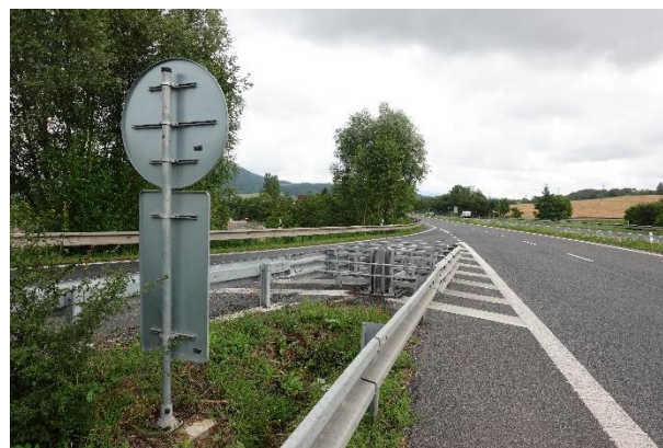
Obrázek 43 – Výhled z místa tlumiče nárazu ve směru proti příjezdu dopravního proudu.
