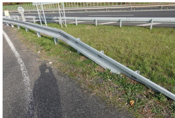
Obrázek 58 – Pohled na konec ocelových svodidel ve větví MÚK.
