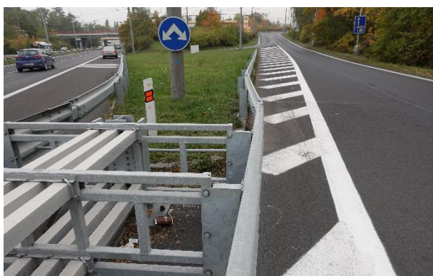
Obrázek 35 – Ukázka pevné překážky (sloup trakčního vedení) v místě dopravního ostrůvku.
