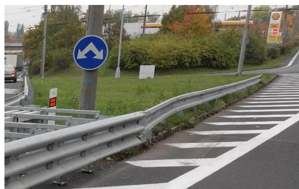
Obrázek 38 – Pohled na ocelové svodidlo v místě vedlejší větve.
