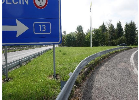
Obrázek 62 – Neopodstatněně umístění svodidel za tlumičem nárazu. (MÚK I/8 x I/13)
