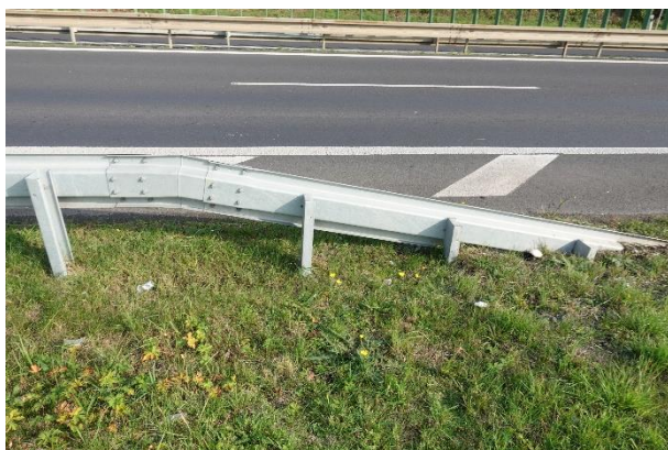
Obrázek 57 – Pohled na zakončení ocelových svodidel na hlavní PK.
