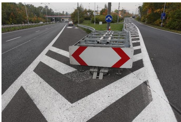
Obrázek 33 – Pohled na sledovanou lokalitu ve směru proti staničení silnice I/13.
