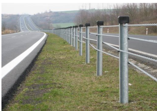
Obrázek 5 – Lanové svodidlo. [13]
