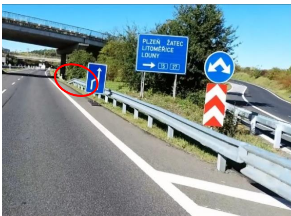
Obrázek 63 – Absence propojení svodidel za tlumičem nárazu. (MÚK I/13 x I/27)
