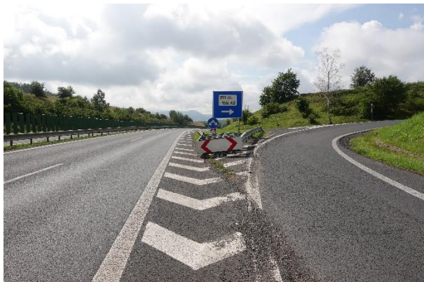
Obrázek 51 – Pohled na sledovanou lokalitu ve směru proti staničení silnice I/13.
