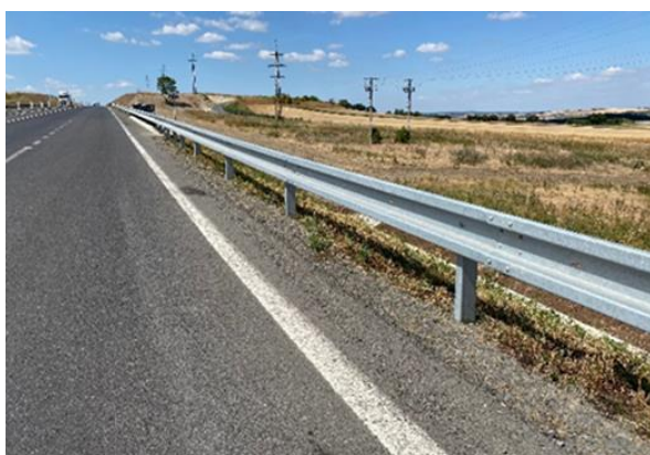
Obrázek 3 – Ocelové svodidlo JSAM-4/N2.
