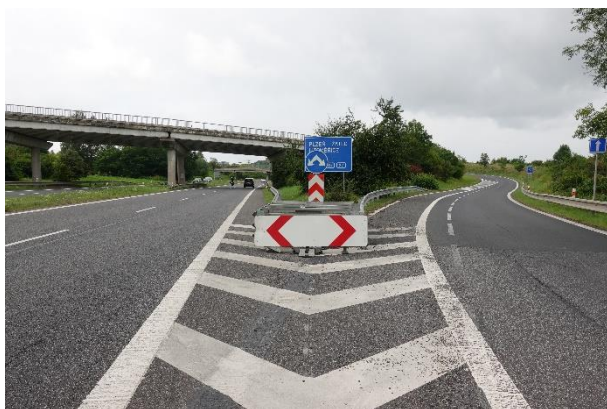
Obrázek 42 – Pohled na sledovanou lokalitu ve směru proti staničení silnice I/13.
