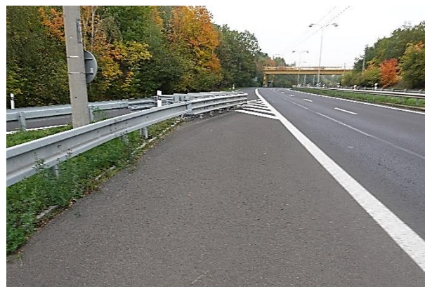
Obrázek 34 – Výhled z místa tlumiče nárazu ve směru proti příjezdu dopravního proudu.
