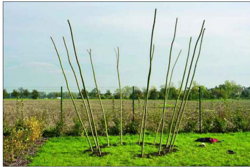
1) Vyhroubení otvorů na zasazení prutů, umístění hlavních tlustých prutů.
