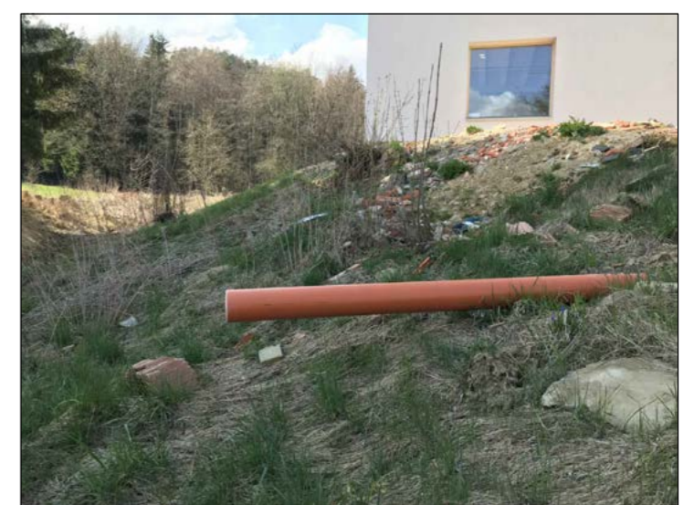
Obr.: Vyústění dešťové kanalizace do recipientu v současném stavu. V návrhu je počítáno s protažením potrubí a jeho zasypáním.
