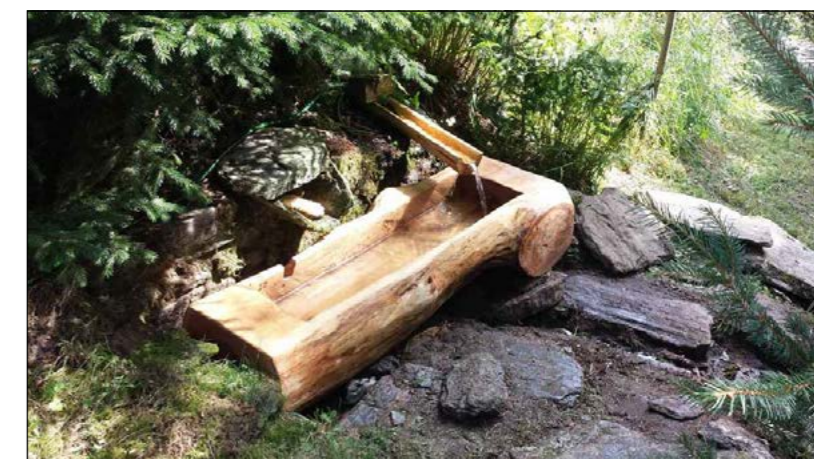
REFERENČNÍ OBRÁZEK Lapač splavenin bude vydlabán do dubového masivu. Korytka pro přítok i odtok budou vytvořena obdobným způsobem.
