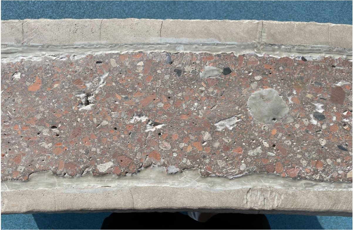
Obr.10: Detail zdi vyplněné rebetonem
