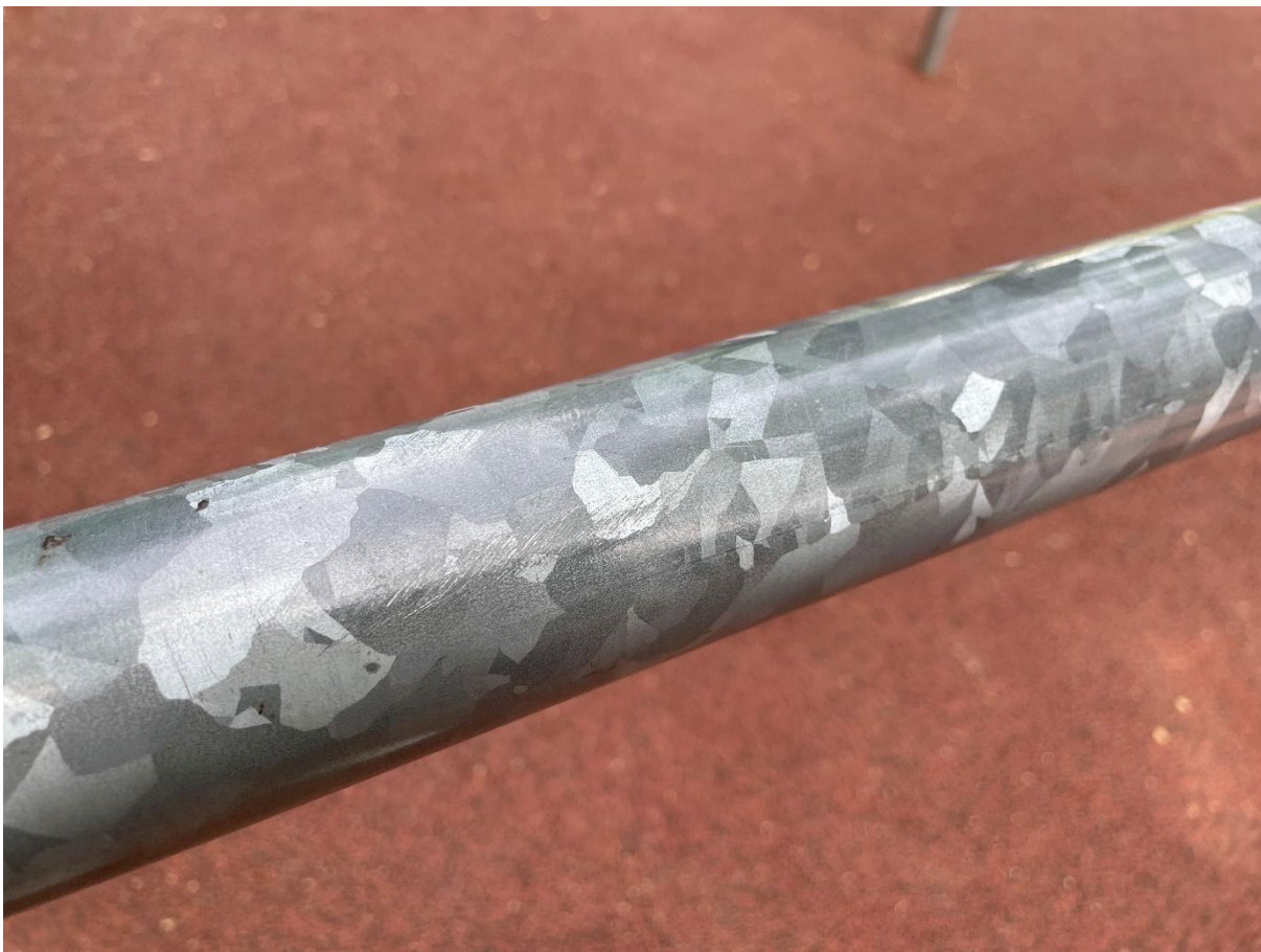
Obr. 65: Povrchová úprava hrazd. Ocel S355, pozink, RAL 9005
