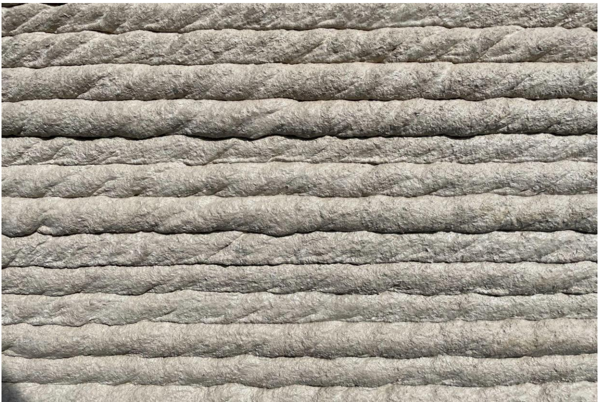
Obr. 11: Detail na strukturu vzniklou 3d tiskem
