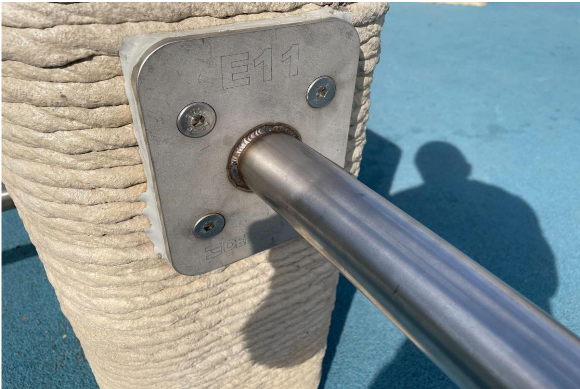
Obr. 13: Detail připevnění hrazdy ke zdi
