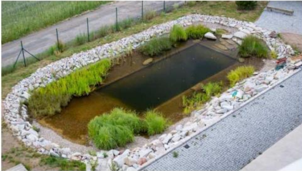
Obr. 8 – Možné riešenie retenčnej vsakovacej nádrže [5]
