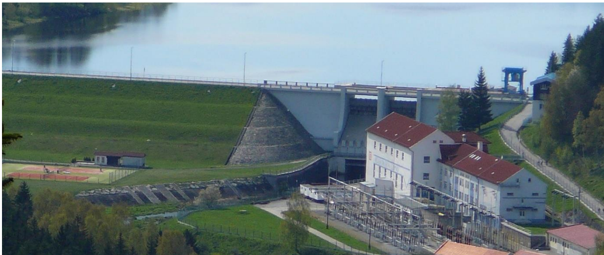
Obrázek 5: Hráz nádrže Lipno I. Jsou zde vidět oba výše zmiňované typy hrází. 51
