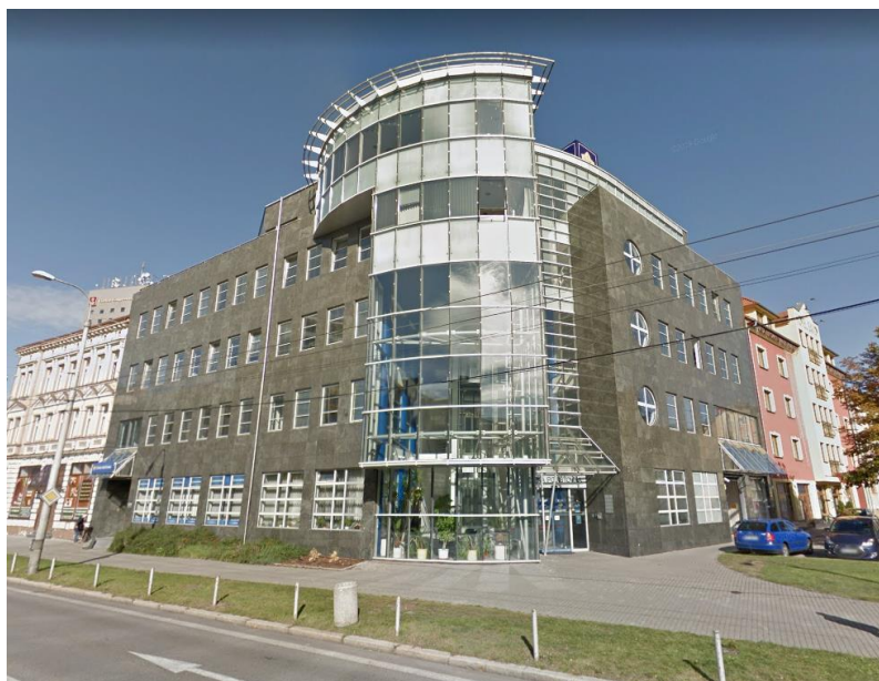
Obrázek 13 Satelitní snímek budovy 6 v Českých Budějovicích [13]
