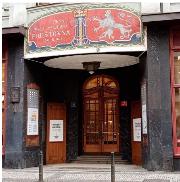
Obrázek 8 Fotografie sídlo Generali České pojišťovny v Spálené [vlastní]
