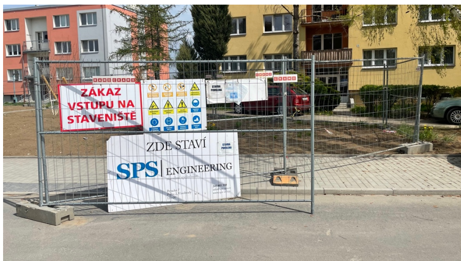
Obrázek 4: Oplocení staveniště s informačními tabulemi [Vlastní]
