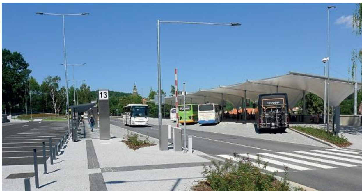
Obr. 6 Autobusové nádraží Český Krumlov (TVSTAV.CZ - STAVEBNÍ PORTÁL 2019)
