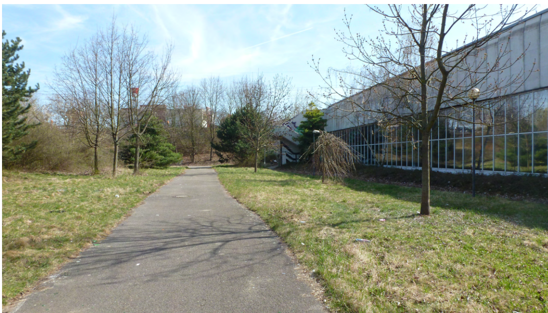
Obrázek 29: Pohled na dnešní park u stanice metra Zličín. Po pravě straně je možné vidět samotnou stanici metra. Plocha parku bude nově použita pro výstavbu parkovacího domu.
