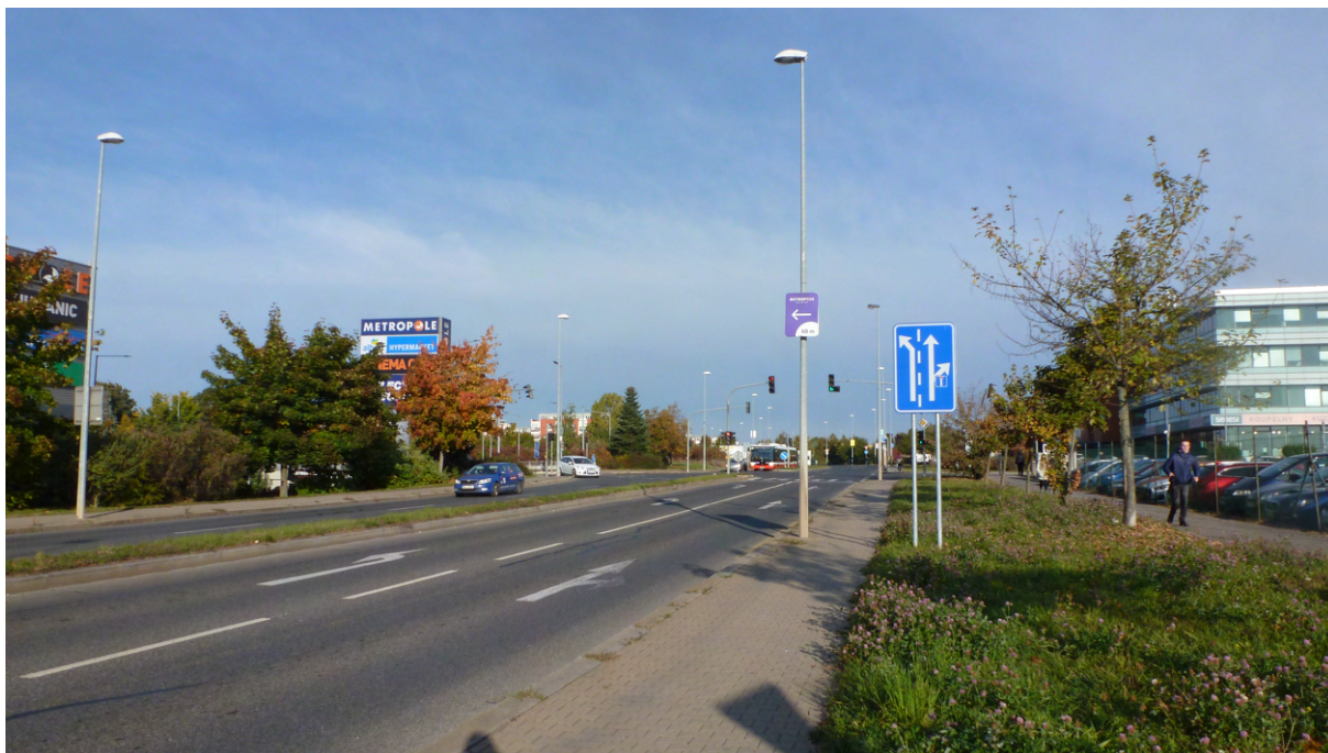
Obrázek 21: Pohled na ulici Řevnickou ve směru od dálnice D5 k severní křižovatce. V těchto místech bude zřízeno parkoviště typu K+R .
