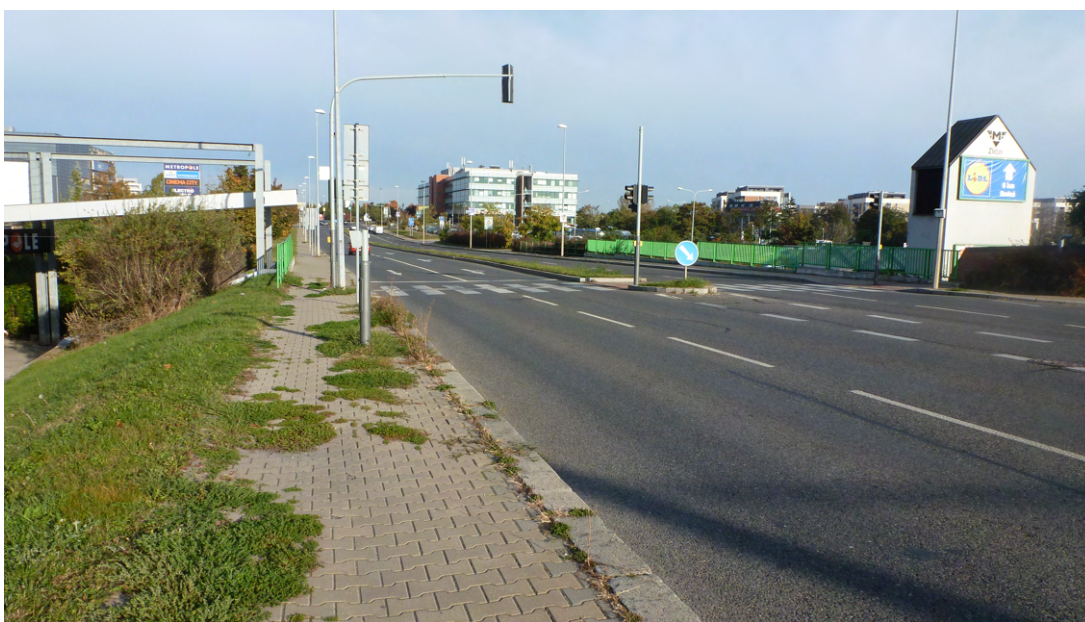
Obrázek 11: Pohled na Řevnickou ulici od dálnice D5. Zhruba v těchto místech by bylo možné zřídit autobusovou zastávku ve směru OC Zličín.
