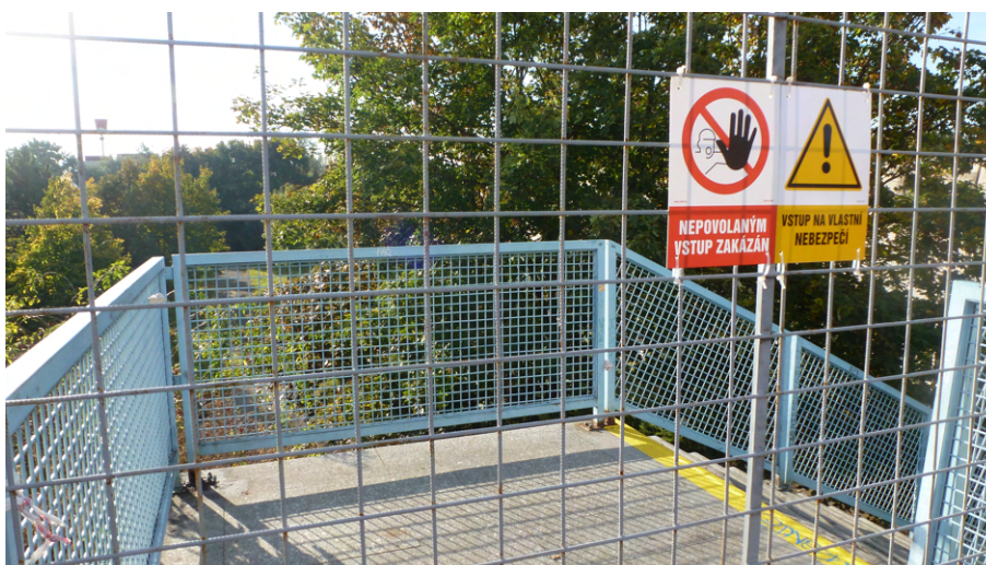
Obrázek 17: Oplocený vstup na přístupové schodiště do parku.
